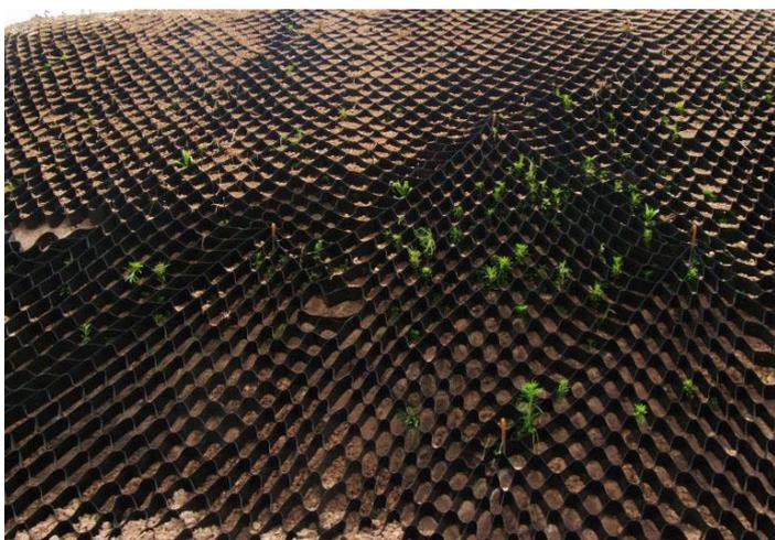
Наиболее популярными являются изделия с размером ячейки 210\*210мм. С высотой 100мм.
