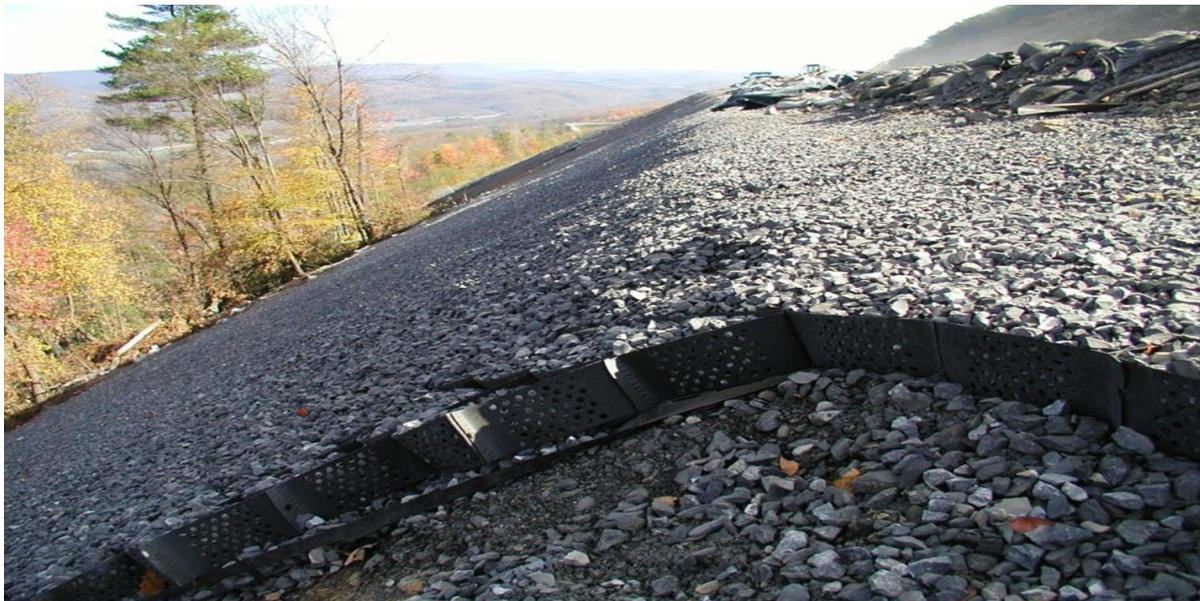
Используя геосетку, можно значительно сократить сроки строительства, снизить расход строительных материалов и уменьшить объемы земляных работ.
