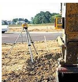
так и плоскость с определенным продольным и поперечным уклоном. Такая конфигурация системы обеспечивает быстрое и точное формирование поверхности, а кроме того, предоставляет дополнительные удобства в работе, например, не требуется создавать опорную поверхность или натягивать струну.
