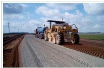
Набор операций и механизмы, используемые в этих технологиях, схожи - на заранее профилированное основание распределяют цемент или известь прицепным распределителем Streumaster SW 10 с автоматической электронной системой дозировки, перемешивают регенератор-смесителем (ресайклер) «CATERPILLAR» RM-500 (350B) с добавлением необходимого количества воды, вновь профилируют и уплотняют.
