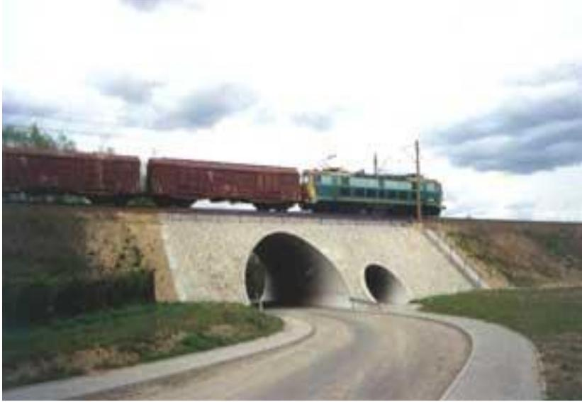
Польша. Реконструкция трехпролетного железобетонного моста. Производство работ осуществлялось без остановки движения ж/д транспорта.
