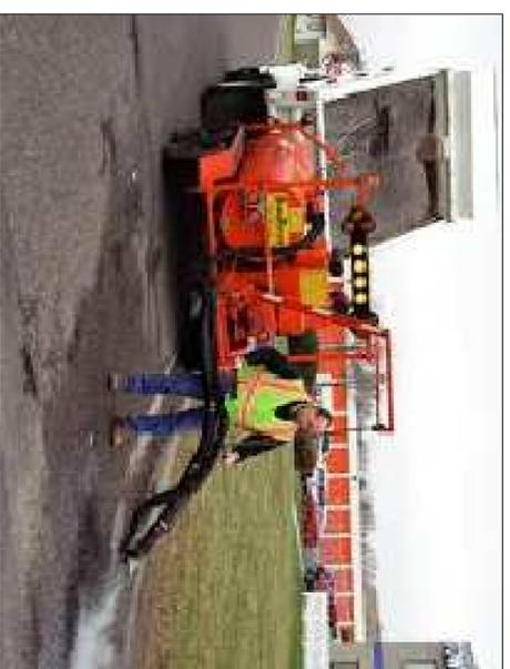
Машины для заделки трещин и ремонта швов обеспечивают очистку трещин от грязи, продувку их сжатым воздухом, просушку, прунтовку стенок и заполнение их мастикой. Окончательной операцией является посыпка обработанной поверхности песком или высевками щебня. Эти машины бывают ручными, перемещаемыми на тележке, прицепными и самоходными. Для заделки трещин применяют ручной механизированный инструмент - пневмомолоты, пневмомолотки, перфораторы и электромолотки.
