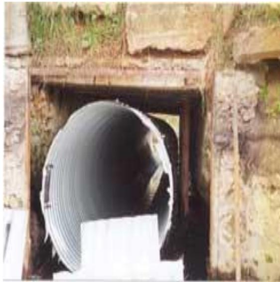
Московская область. Ремонт плитного моста методом гильзования.2001г.
