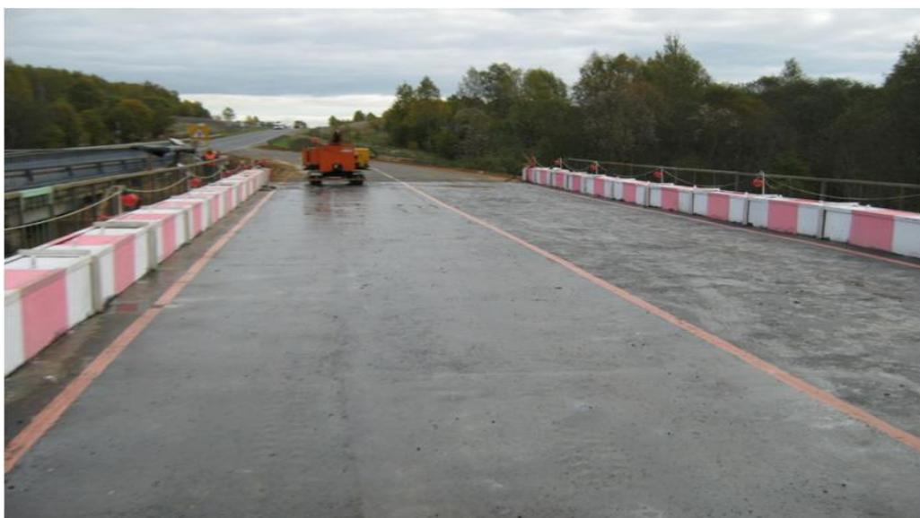
Гидроизоляционные материалы "Мостопласт", "Инопластмост"
