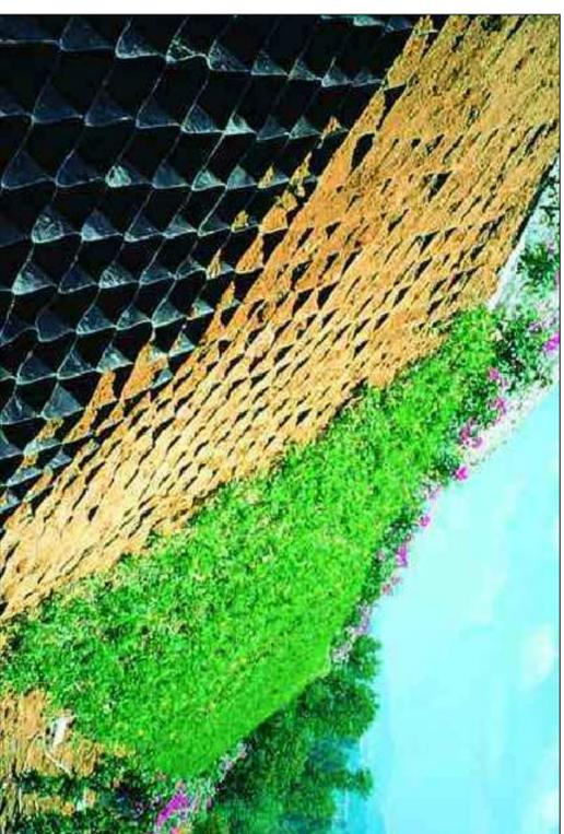
Используя геосетку, можно значительно сократить сроки строительства, снизить расход строительных материалов и уменьшить объемы земляных работ.
