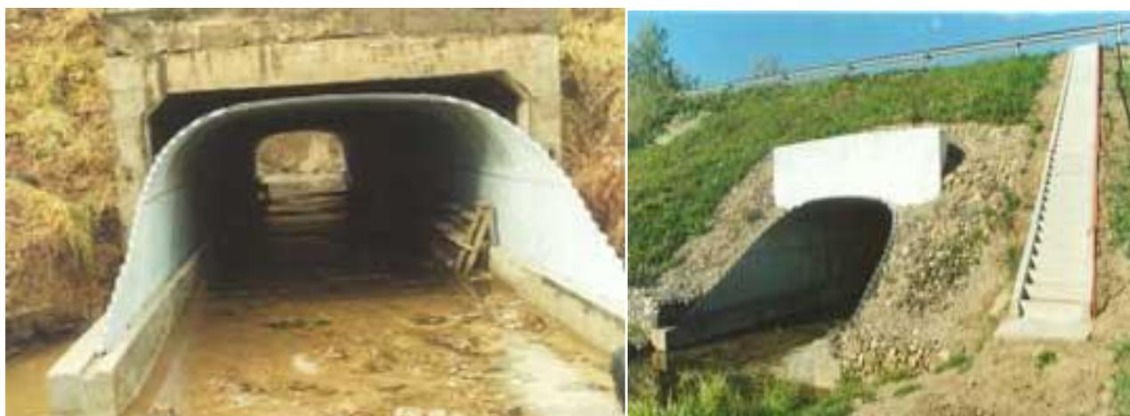
Московская область. Ремонт прямоугольной железобетонной трубы с применением сборной металлической гофрированной арки методом гильзования. 2000г.
