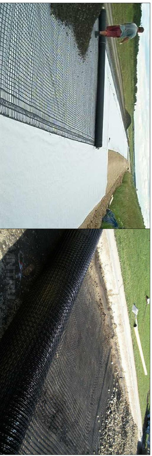
Геотекстиль превратился в один из наиболее популярных материалов в современном дорожном строительстве. При возведении магистралей и автомобильных дорог полотно геотекстиля помещается между слоями щебня и глины. Это исключает вероятность смешивания фракций, обеспечивает защиту бетонного или асфальтового покрытия от провалов и деформаций.
