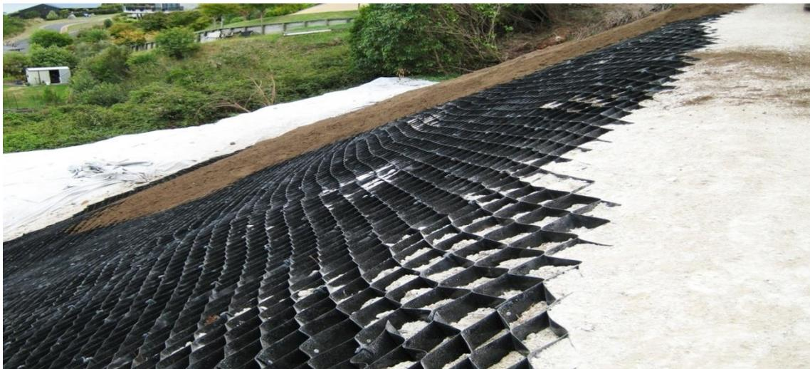
В зависимости от угла заложения откоса, его грунтового состава и материала заполнения ячеек, подбирается необходимая длина анкера.
