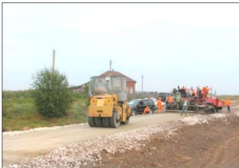
Рис. 5.13. Строительство оснований и покрытий из полимерцементогрунтовых смесей с применением ресайклера
