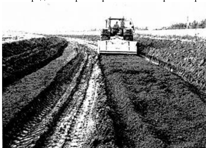
Рис. 2.2. Обработка грунта стабилизатором T-RRP навесной фрезой (аэропорт Шереметьево, 2006 г.)
