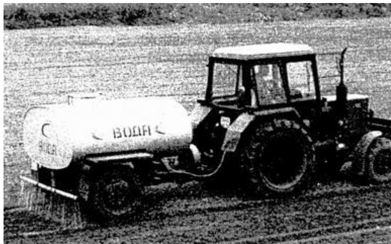
Рис. 2.1. Распределение раствора стабилизатора Roadpaker Plus
