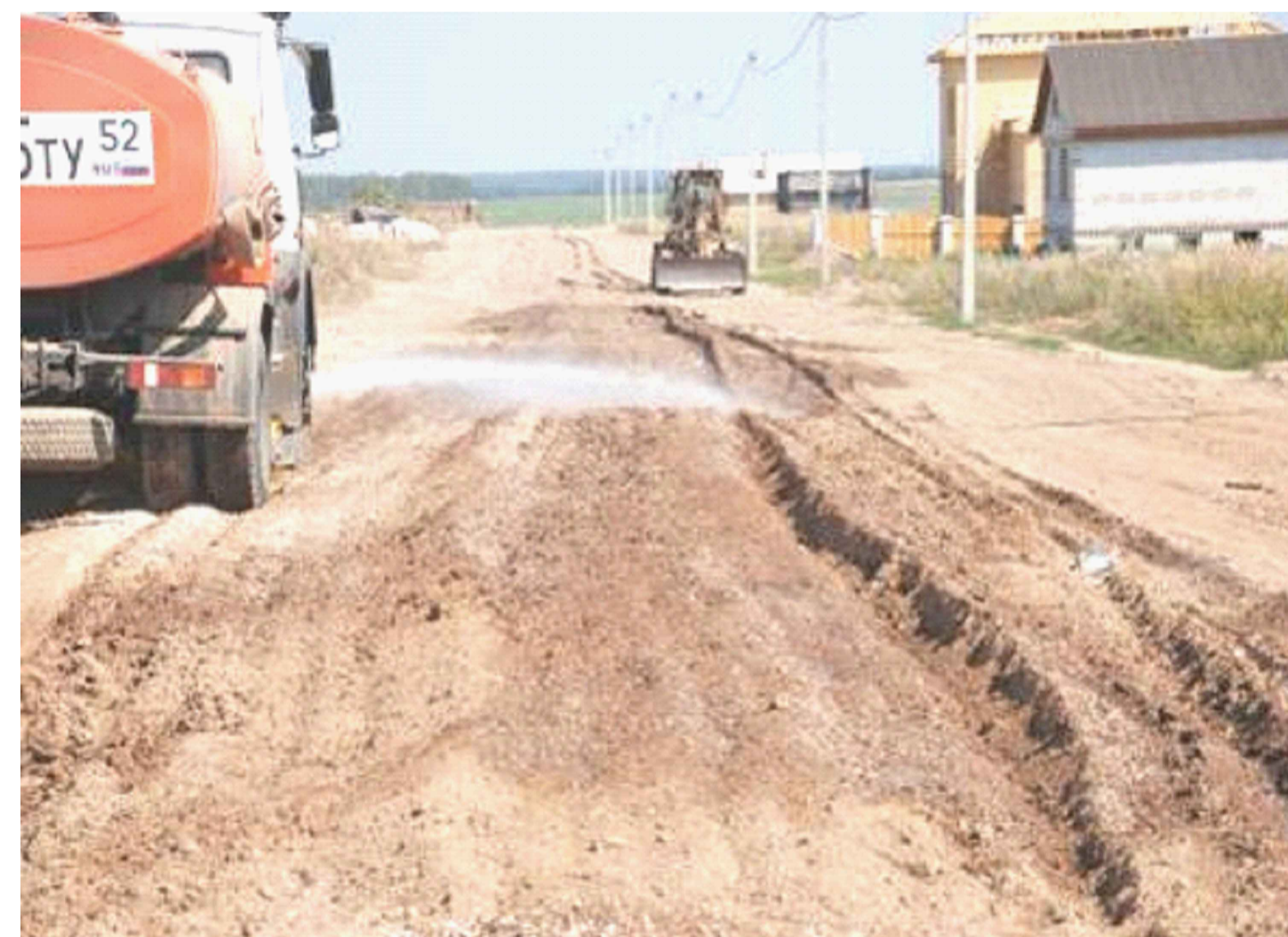
Пролив грунта стабилизатором
