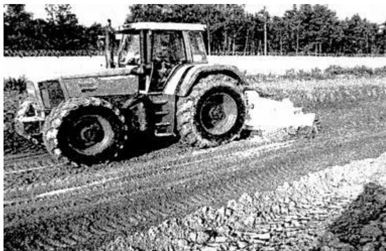
Рис. 1.1. Устройство основания из укрепленного грунта методом смешения на дороге
