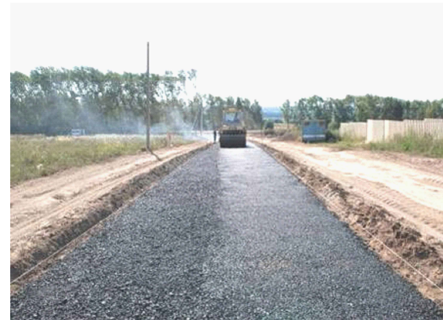
Устройство асфальтобетонного покрытия
