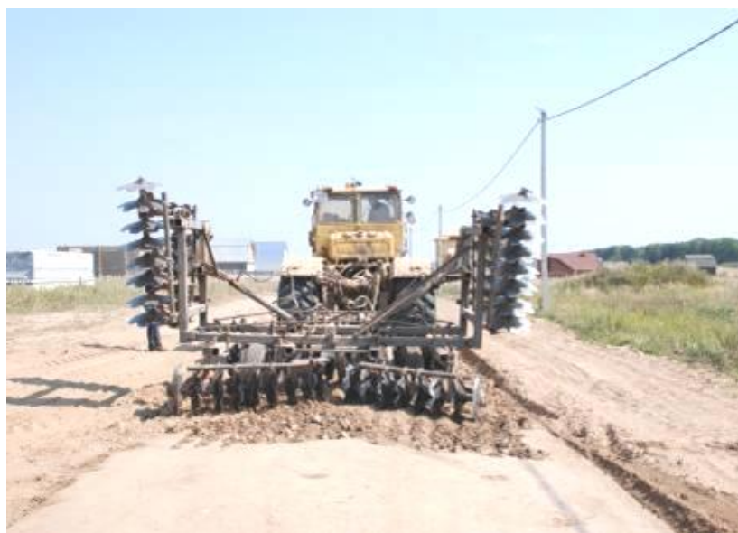
Рис. 5.9. Взрыхление и измельчение существующего грунта основания
