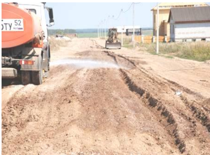
Рис. 5.10. Пролив грунта стабилизатором
