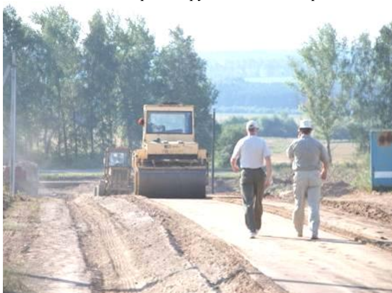
Рис. 5.11. Уплотнение грунта
