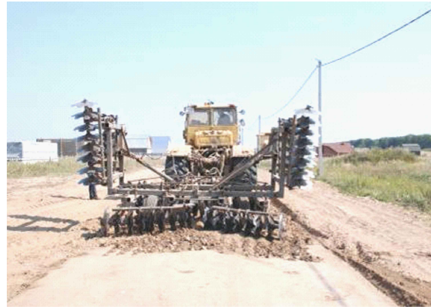
Взрыхление и измельчение существующего грунта основания
