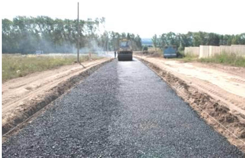
Рис. 5.12. Устройство а/б покрытия
