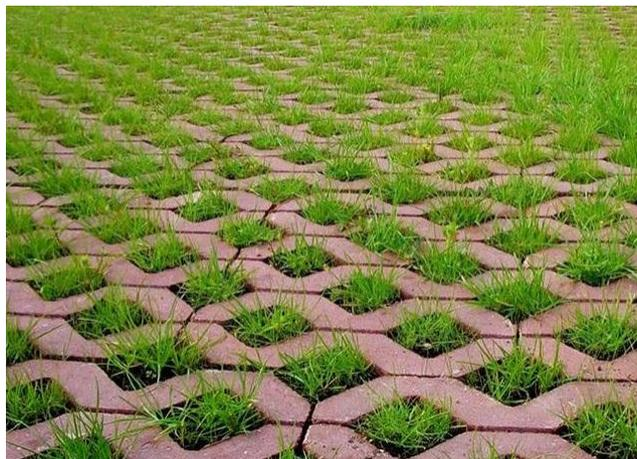
Рис. 3. Бетонная решётка для газонов.
