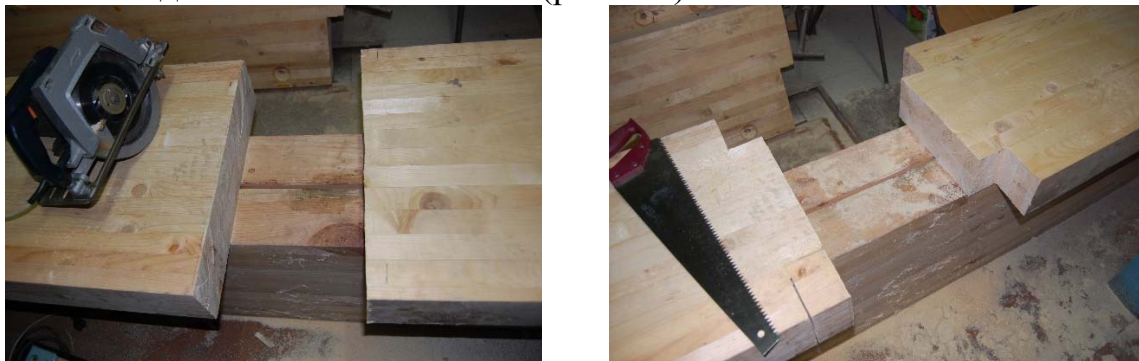
Рис. 4.6 – Вырез «четвертей» под соединительный сварной элемент
