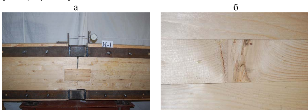
Рис. 4.14. Основные повреждения жёсткого узла клеёной деревянной балки: а – деформация балки под нагрузкой; б – нормальная трещина поперёк волокон балки
