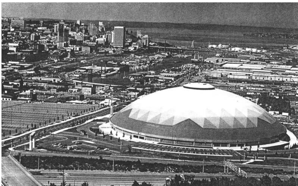
Рис. 2. Купольное покрытие стадиона в г. Такома (США) диаметром 162 м
