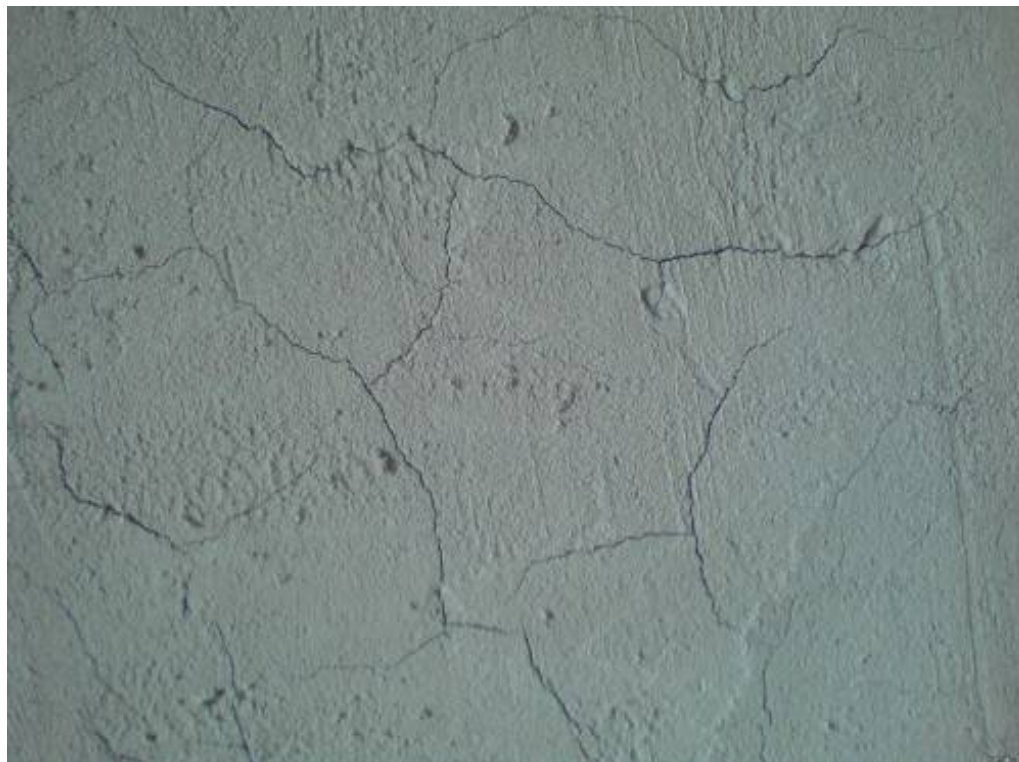
Рис. 4.1. Фотография фасада здания по улице Циолковского, г. Пенза, после первого года эксплуатации покрытия
