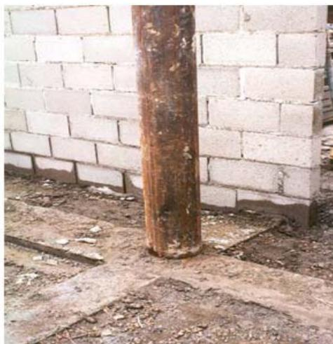
Рис. 2.1. Элемент узла сопряжения трубобетонной колонны с перекрытием (а), вид узла сопряжения в строящемся здании (б)
