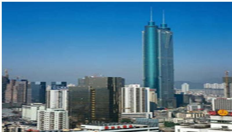
Рис. 2. Здание с каркасом из трубобетона на площади Сайгэ в Шэньчжэне, КНР (72 этажа)
