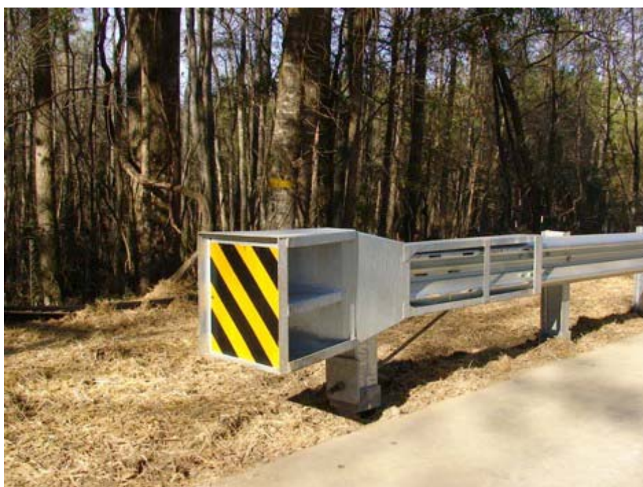
Рисунок 29- Обработанный край ограждения прямоугольным буферным элементом
