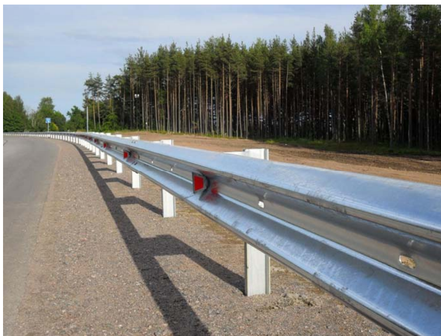
Рисунок 8- Ограждение барьерного типа 11ДО
