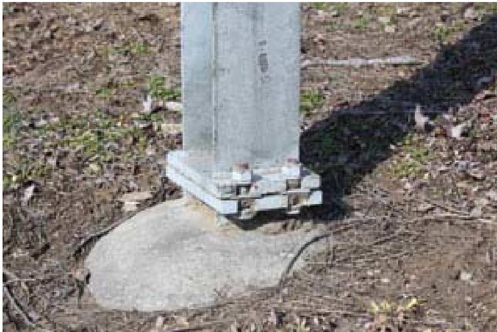
Рисунок 15- Устройство крепления столба
