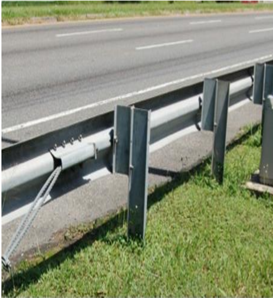
Полужёсткое ограждение с применением троса
