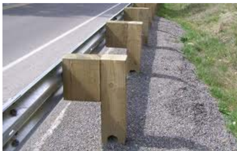
Рисунок 24- Полужёсткое ограждение с деревянными стойками
