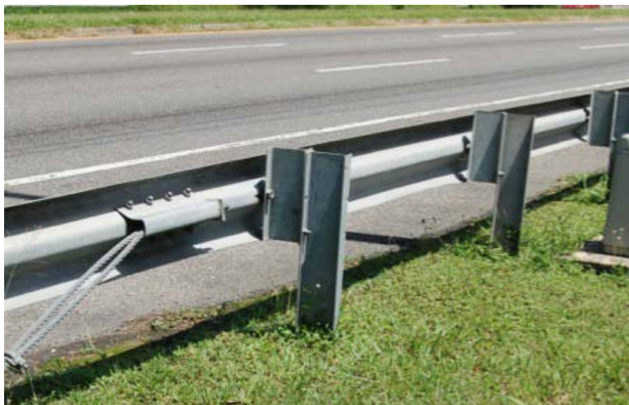
Рисунок 23- Полужёсткое ограждение с применением троса
