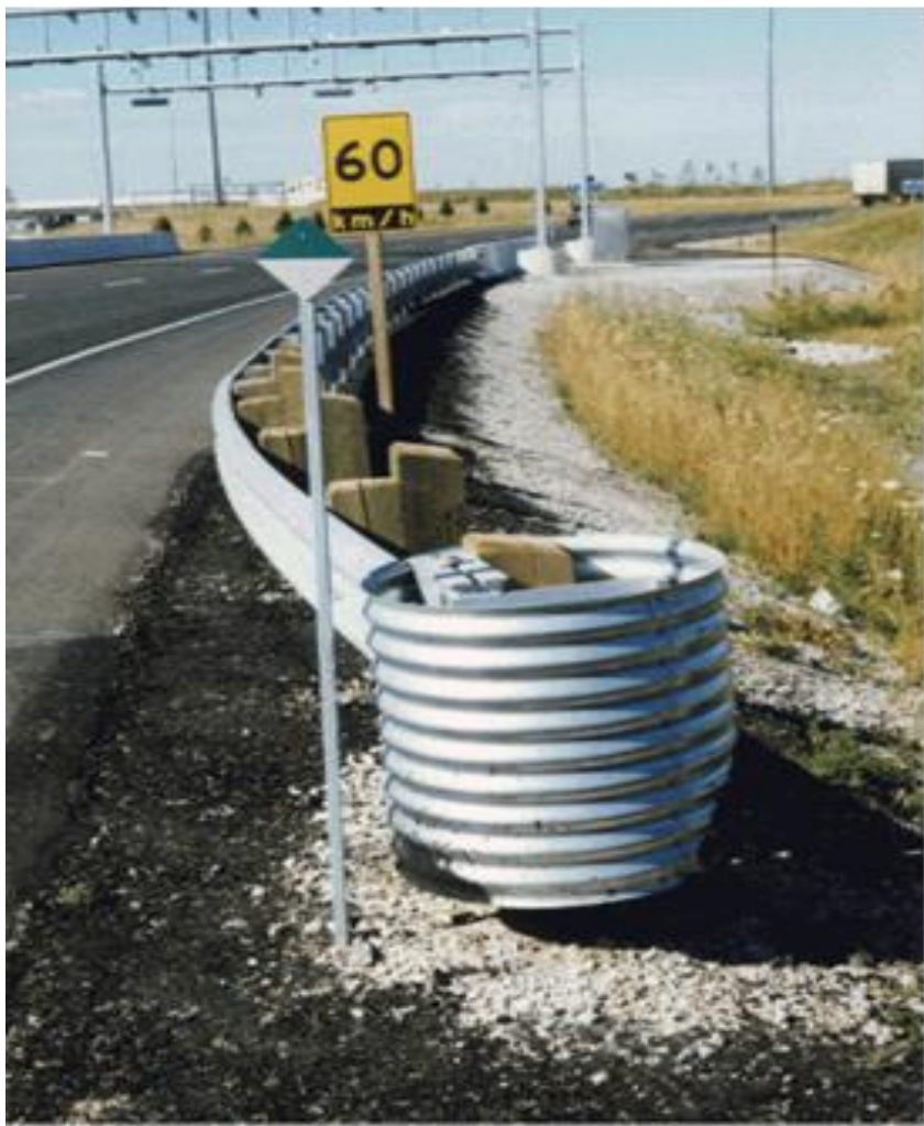
Энергопоглощающий буферный элемент в виде трубы
