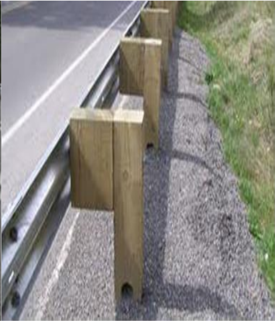
Полужёсткое ограждение с деревянными стойками
