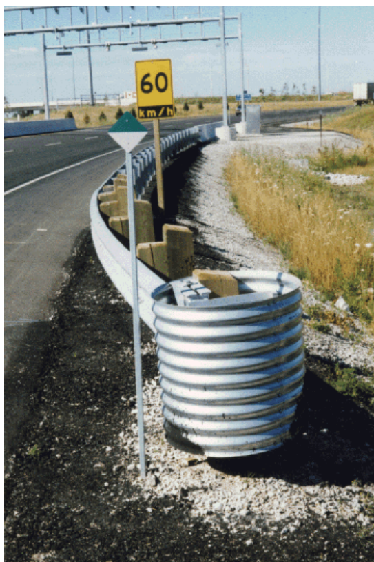
Рисунок 28- Энергопоглощающий буферный элемент в виде трубы
