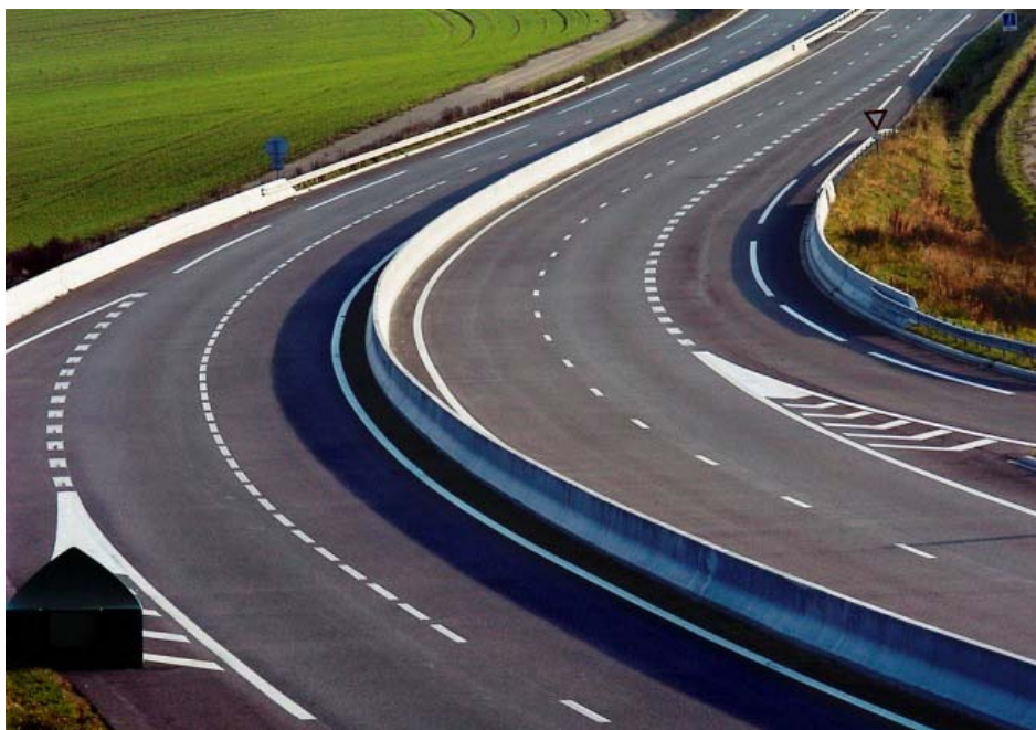
Рисунок 10- Бетонные парапетные ограждения на автомагистрали
