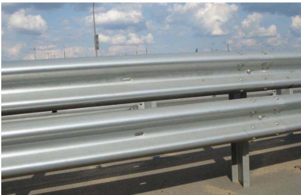
Рисунок 9- Ограждение барьерного типа 11МО
