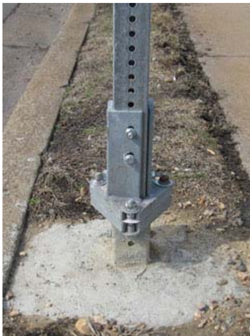
Рисунок 18- Крепление столба болтами
