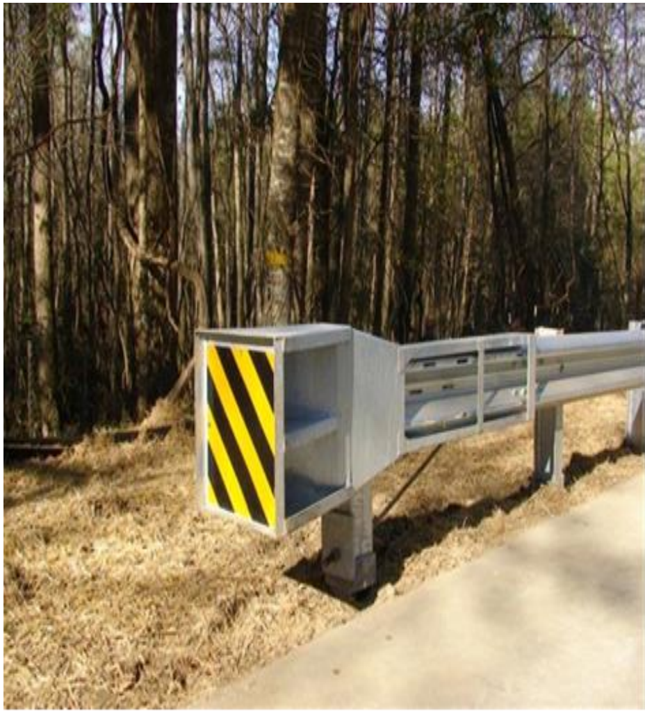
Энергопоглощающий буферный элемент с прямоугольным основанием
