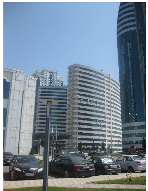
Вновь отстроенный центральный район Грозного.
