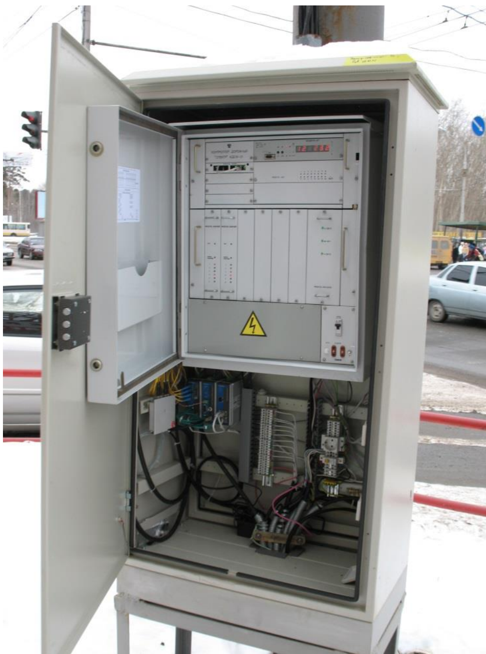
Рисунок 2.12 – Внешний вид дорожного контроллера СПЕКТР - КДСФ
