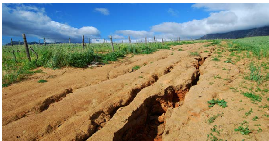
Рисунок 7 - Образование промоины по колеям грунтовой дороги
