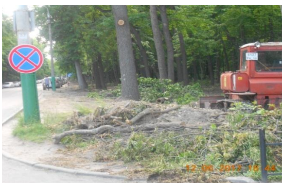
Рис. 2.6 Работы по обустройству тротуара
