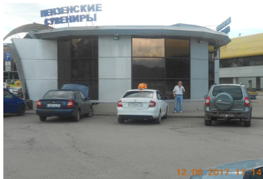
Рис. 2.17 Отсутствие дорожных знаков и разметки на площади Пенза-1
