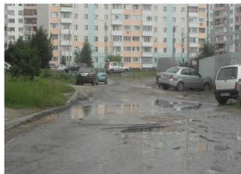
Неудовлетворительное состояние проезжей части дороги по ул. Озерной
