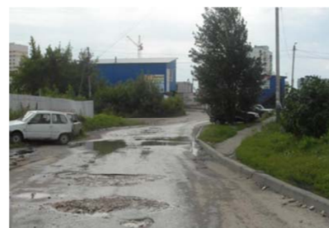
Неудовлетворительное состояние проезжей части дороги по ул. Озерной
