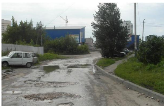
Рис. 2.5. Фотоотчет о неудовлетворительном состоянии проезжей части дороги по ул. Озерной
