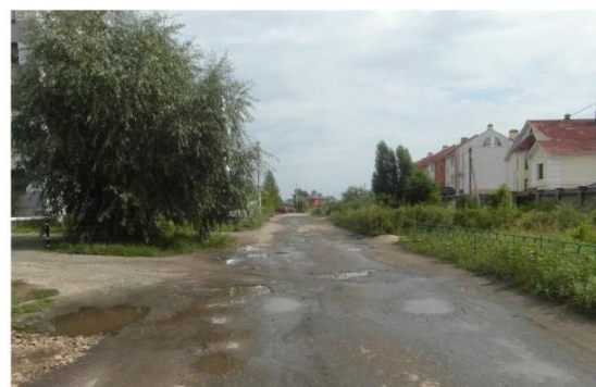
Рис. 2.5. Фотоотчет о неудовлетворительном состоянии проезжей части дороги по ул. Озерной
