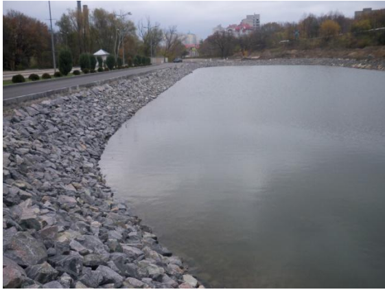
Рис.26 Варианты укрепления береговой линии водоемов.
