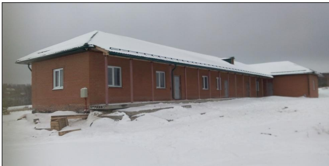
Рисунок 14 – Строящийся церковный дом
