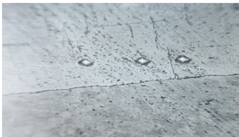
Рис. 3.14 Трещины в покрытии электролитического железа
