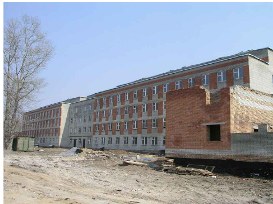
Существующий фасад в осях 9-18
