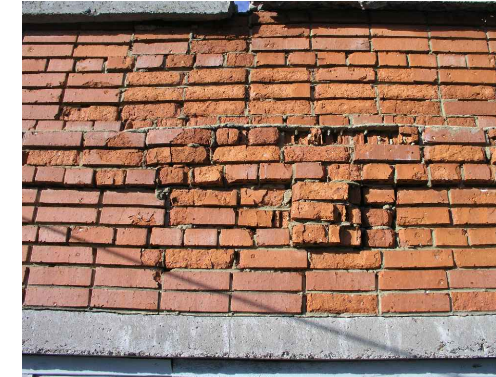
Разрушение кирпичной кладки в наружной стене
