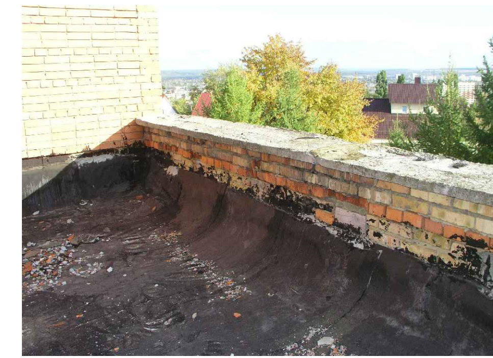
Разрушения на кровле
