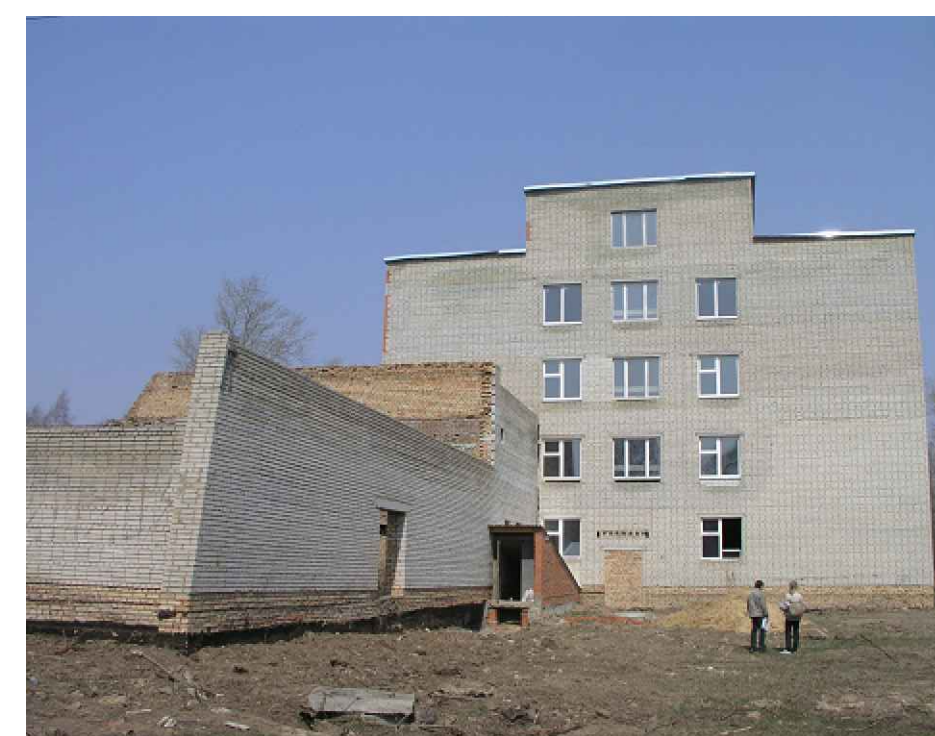
Существующий фасад в осях В-Н
