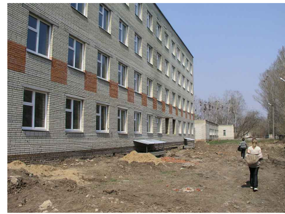
Существующий фасад в осях 12-9
