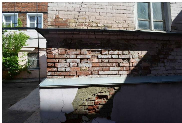
Намокание и разрушение кирпичной кладки
