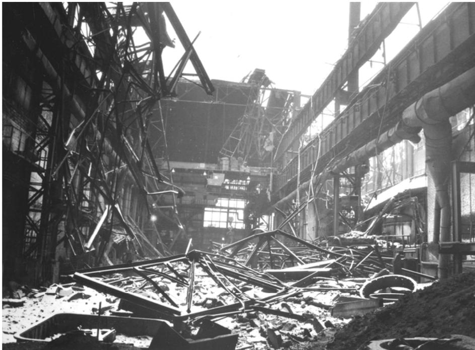
Рис. 1. Общий вид обрушения конструкций покрытия цеха литейно-арматурного завода в г. Пензе
