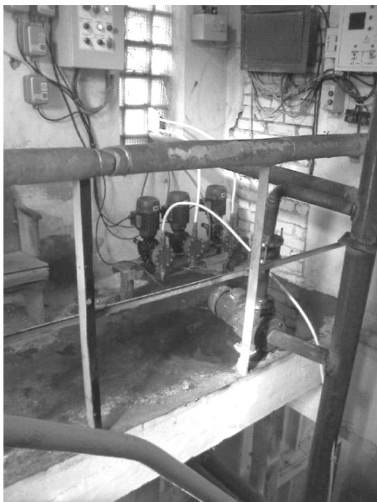
Рис.2. Общий вид насосов-дозаторов
