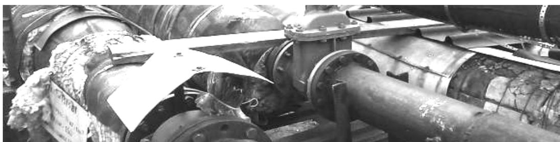
Рис. 2. Разрушение конструкции тепловой сети, проложенной надземно
