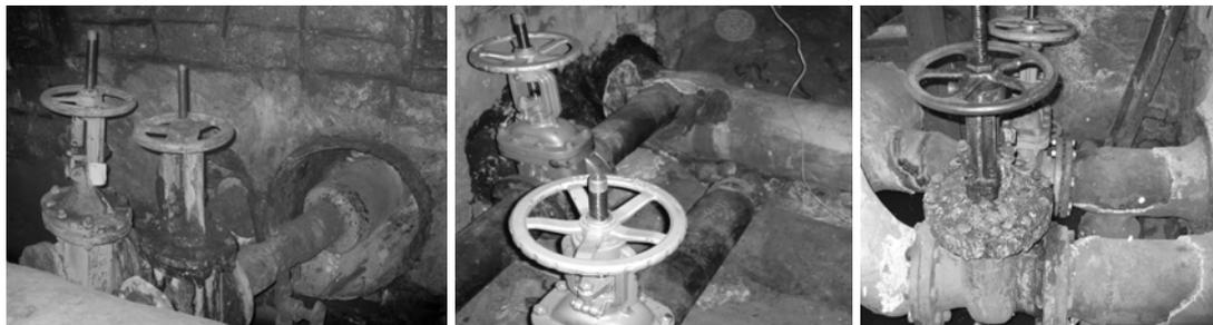
Рис. 1. Внешняя коррозия оборудования и трубопроводов тепловых сетей при подвальной прокладке
