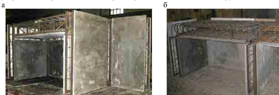
Рис. 1. Фрагменты помещений из армоблоков с несъемной сталефибробетонной опалубкой с различными вариантами стыков:
