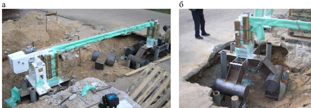
Рис. 5. Монтаж ПТУ на металлоконструкцию гашения импульса удара: а – общий вид; б – фрагмент
