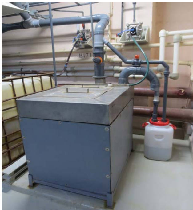
Рис. 2. Общий вид промышленной установки для обезвреживания отработанных медно-аммиачных травильных растворов локальных канализационных очистных сооружений АО «НПП «Рубин»
