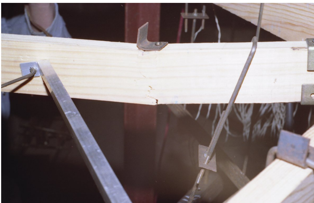
Рис. 6. Разрушение ребра пирамиды C51-4,79 в растянутой зоне
