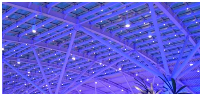
Рис. 16. Перекрытие торгового центра «Авиапарк» в Москве
