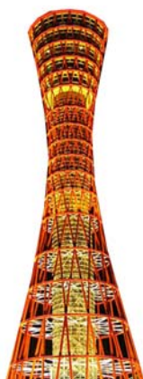
Рис. 5. Башня в порту Кобе
