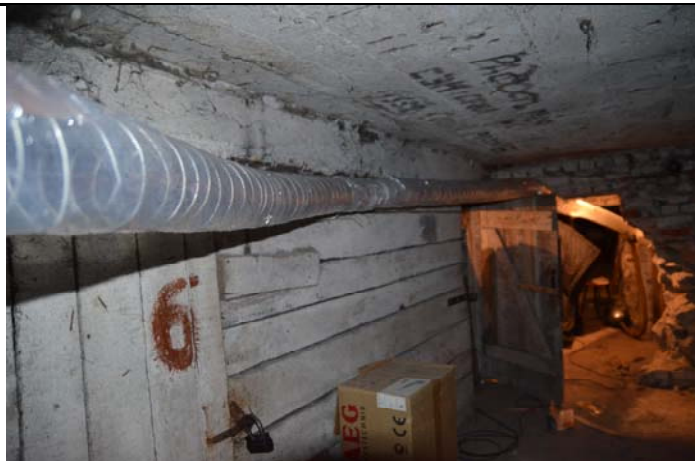
Рис. 1. Установка воздуховода в подвальном помещении
