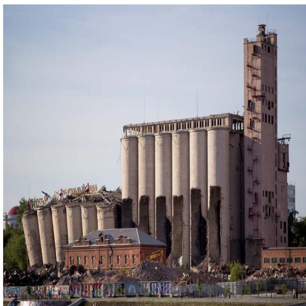
Рис. 2. Обрушение элеватора Екатеринбургского мукомольного завода
