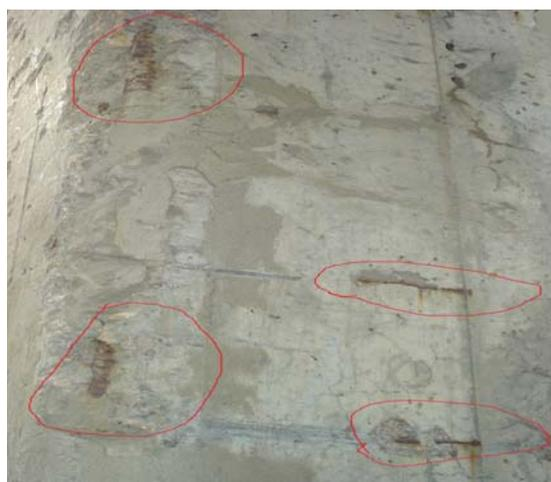
Рис. 3. Оголение рабочей арматуры колонны здания
