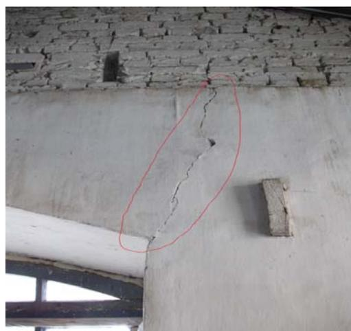
Рис. 4. Вертикальная трещина (с шириной раскрытия более 5 мм)
