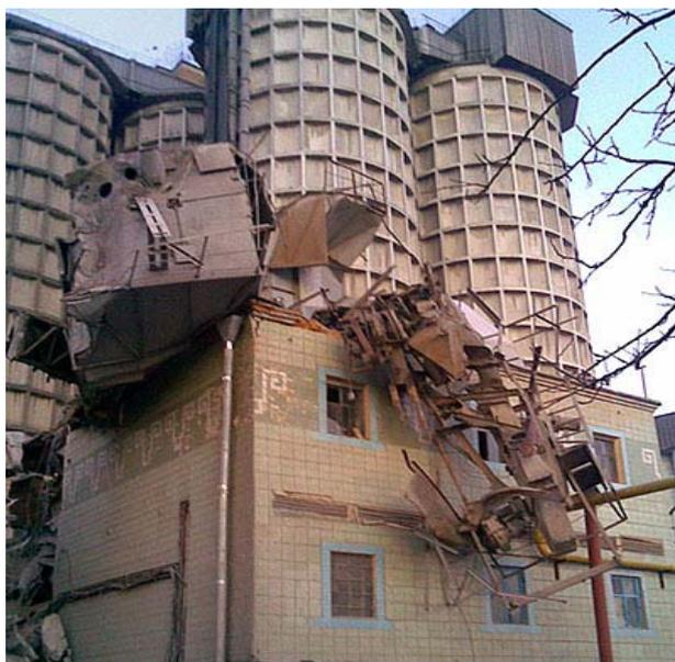
Рис. 1. Обрушение 42-метровой силосной колонны ЗАО «Бендерский комбинат хлебопродуктов»
