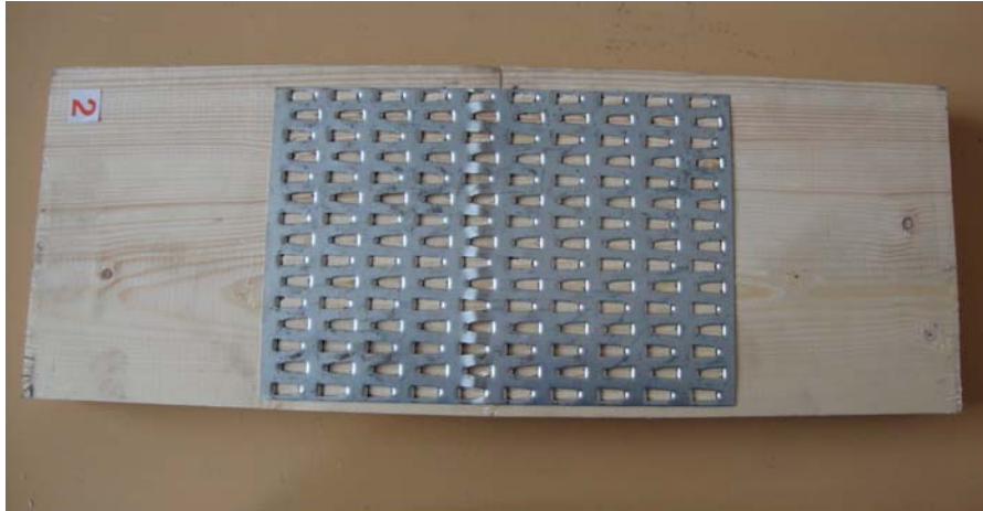
Рис. 6. Деформации перегородок между зубцами (ряд пластин, примыкающих к стыку досок слева)
