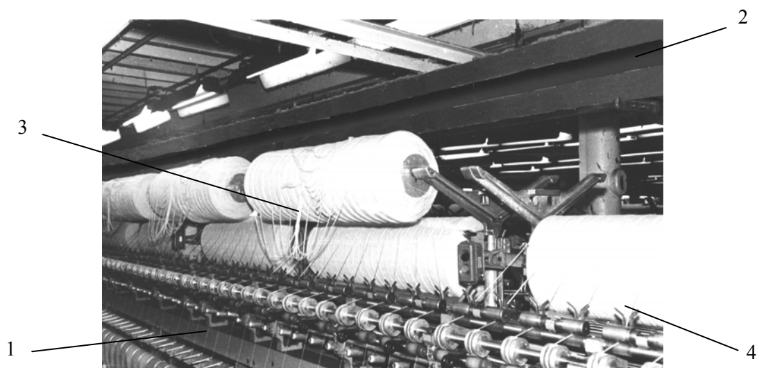
Рис. 2. Установка воздухораспределителя на рамке прядельной машины в зоне ровницы:
