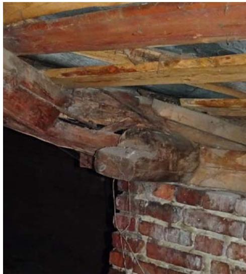
Рис. 4. Сгнившее в опорной части диагональное стропило ендовы
