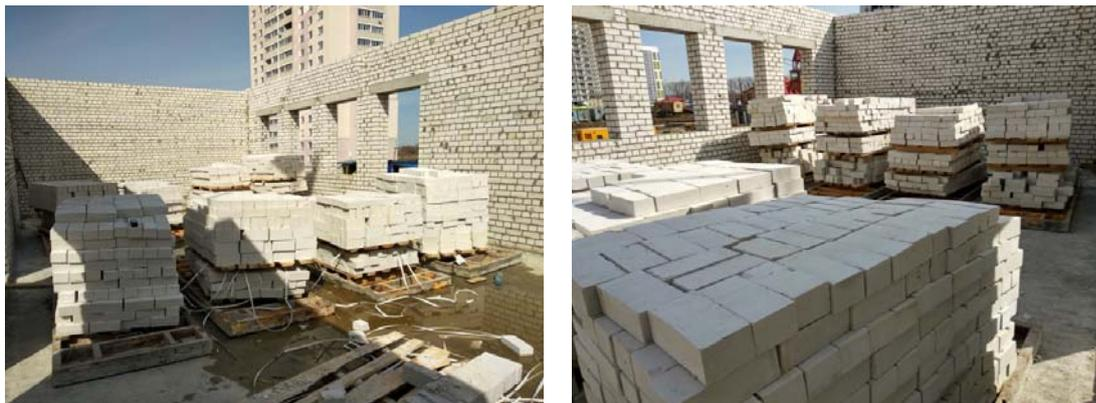
Рис. 2. Нагружение монолитного перекрытия (по заранее подготовленным площадкам распределения нагрузки)
