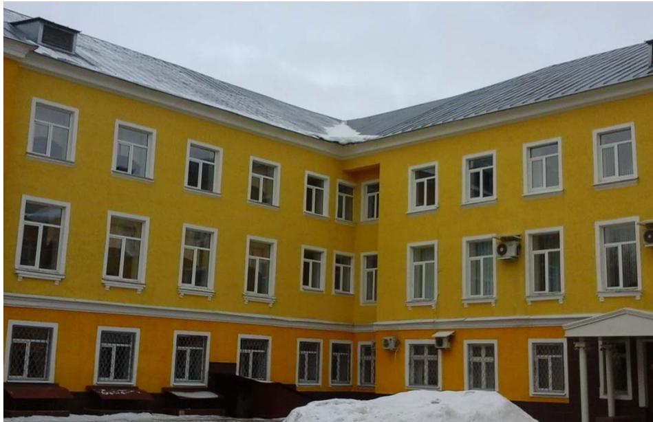
Рис. 3. Скопление снега в нижней части ендовы
