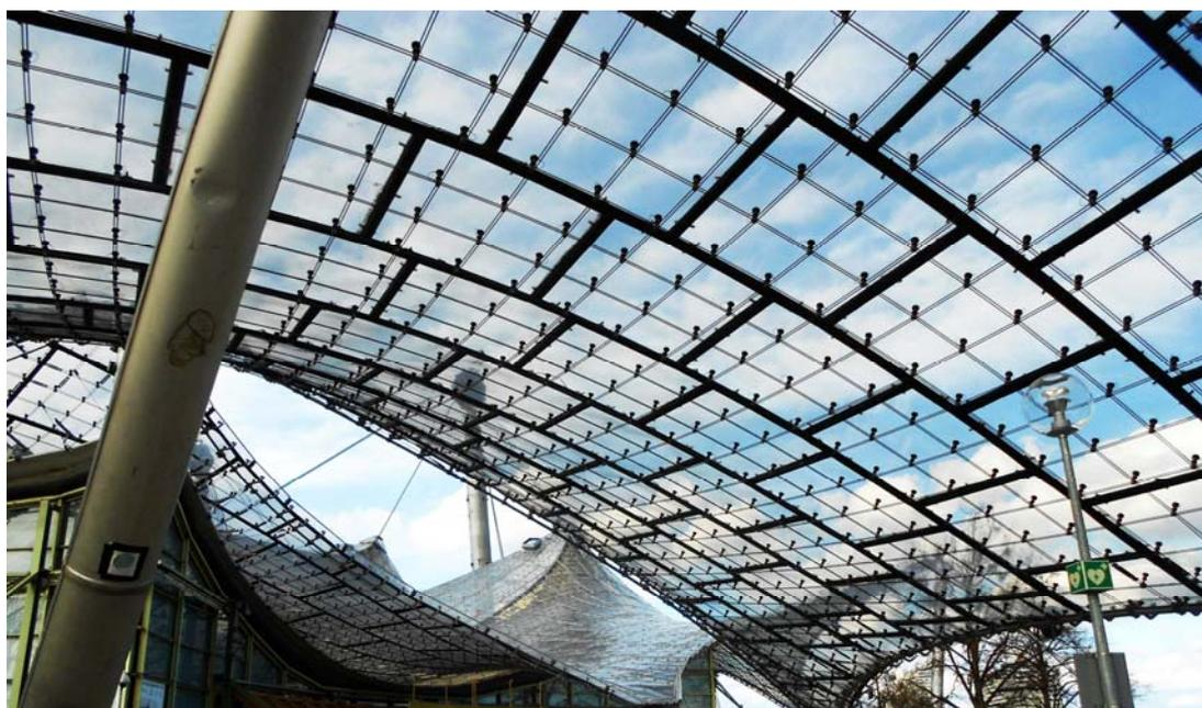
Рис. 10. Фрагмент прозрачного перекрытия.
