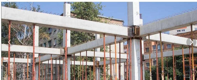
Рис. 1. Фрагменты сборно-монолитного каркаса системы «Аркос»: а – узел сопряжения ригеля с колонной; б – временные стальные стойки под ригелями
