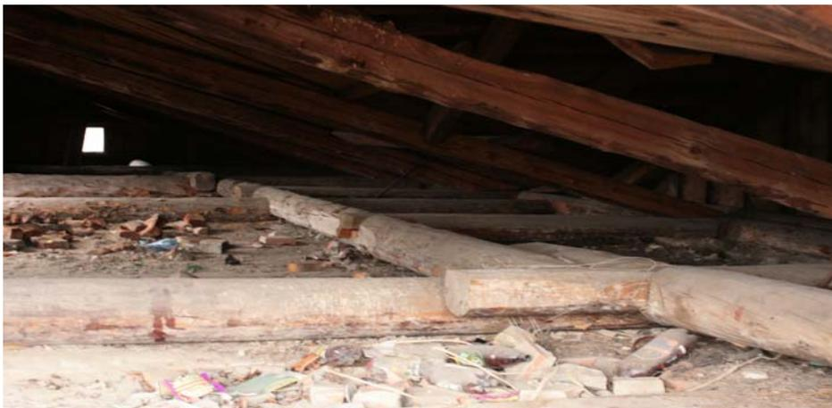
Рис. 7. Узел соединения бревен нижнего пояса и продольного бревна
