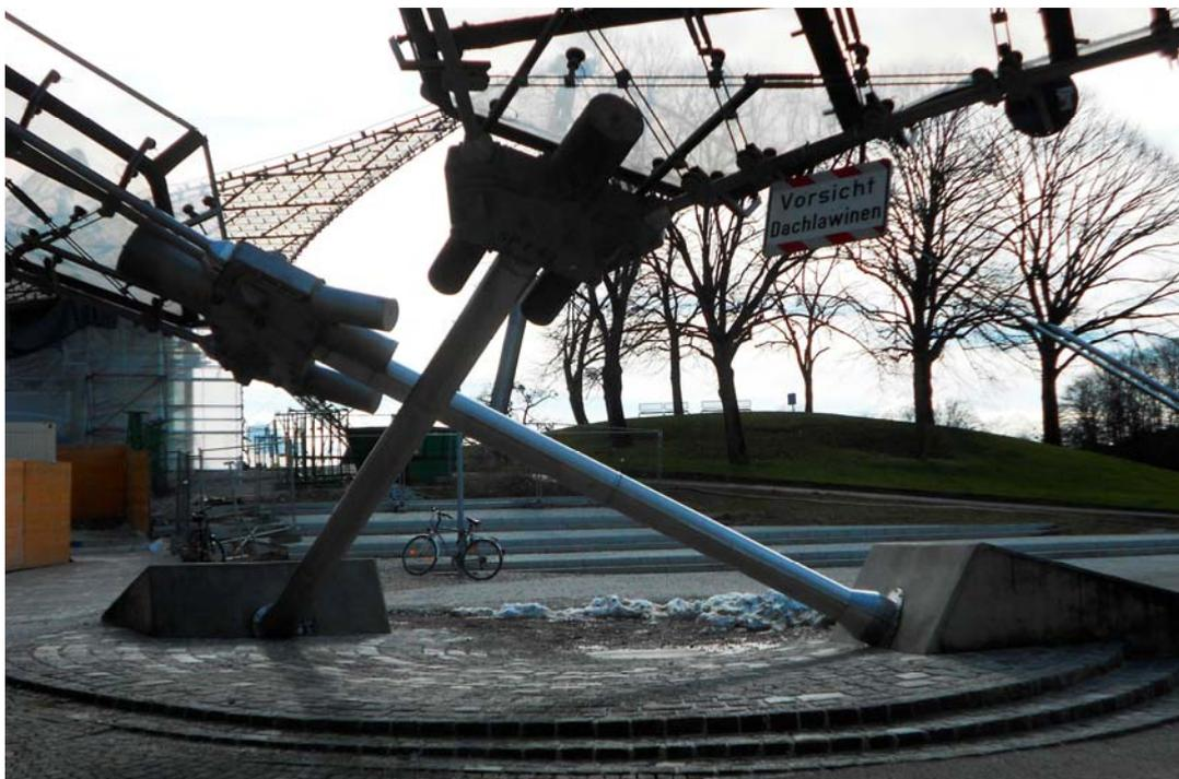
Рис. 19. Конструктивные элементы анкерного сцепления с фундаментом угловых концов прозрачного перекрытия. Фото авторов, март 2018 г.
