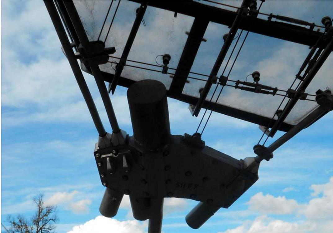
Рис. 18. Конструктивные элементы углового конца прозрачного перекрытия.
