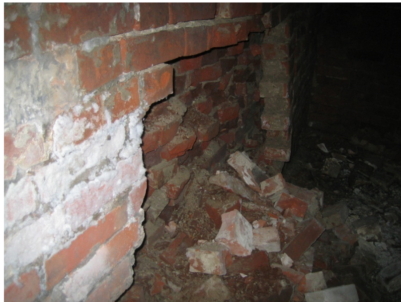
Обрушение засолённой стены под действием бокового давления грунта из-за солевой коррозии кладочного раствора (г. Пенза, бывший Мясной пассаж, постройка XIX в.)
