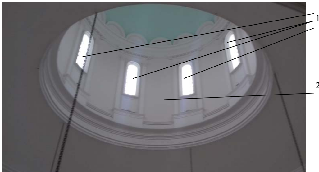
Рис. 3. Месторасположение автоматизированных притворов в барабане главного купола Спасского кафедрального собора в г. Пензе для удаления воздуха из зала:
