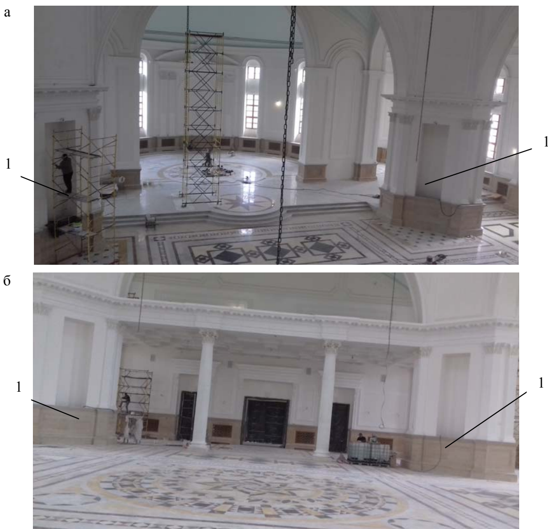
Рис. 2. Месторасположение приточных воздухораспределителей в главном зале богослужения Спасского кафедрального собора в г. Пензе: а – восточная сторона собора; б – западная сторона собора; 1 – место подачи приточного воздуха в зал богослужения
