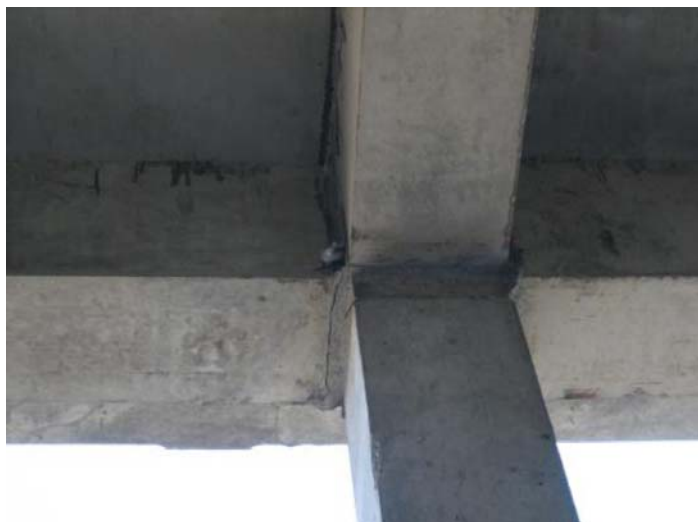
Рис. 1. Раскрытие трещин в приопорной зоне
