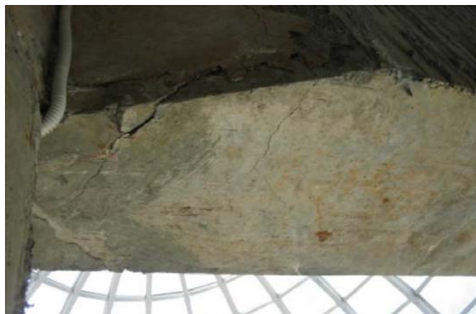
Рис. 2. Раскрытие наклонных трещин в приопорной зоне
