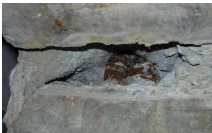
Рис. 3. Непробетонированные участки, обнаруженные при обследовании
