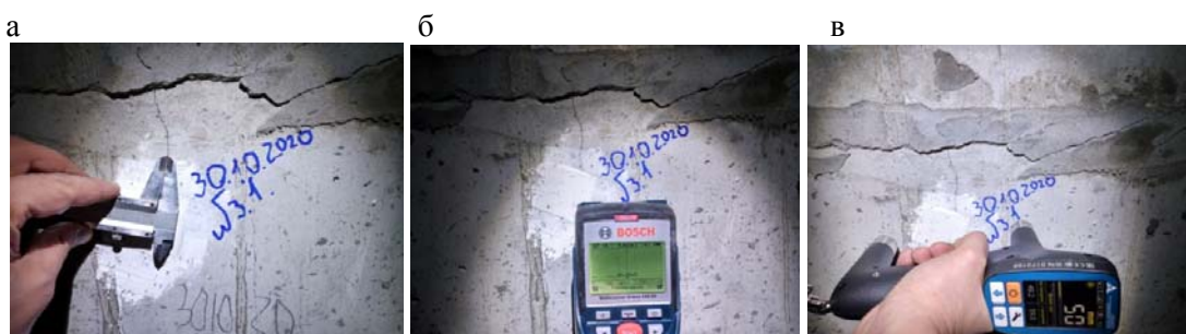
Рис. 2. Определение параметров дефекта в виде трещины: а – штангенциркулем; б – прибором BoschWallScanner D-tect 150; в – ультразвуковым тестером UK1401
