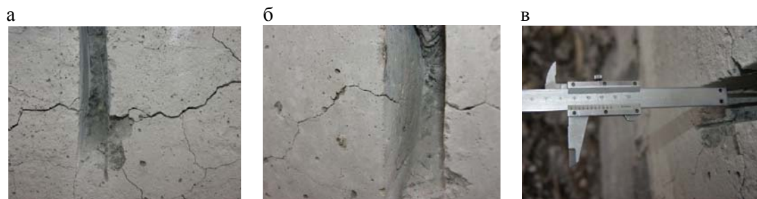
Рис. 1. Глубина и расположение наиболее раскрытых трещин
