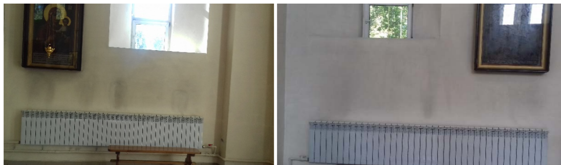
Рис. 1. Общий вид загрязнения внутренней поверхности стены и икон над отопительным прибором
