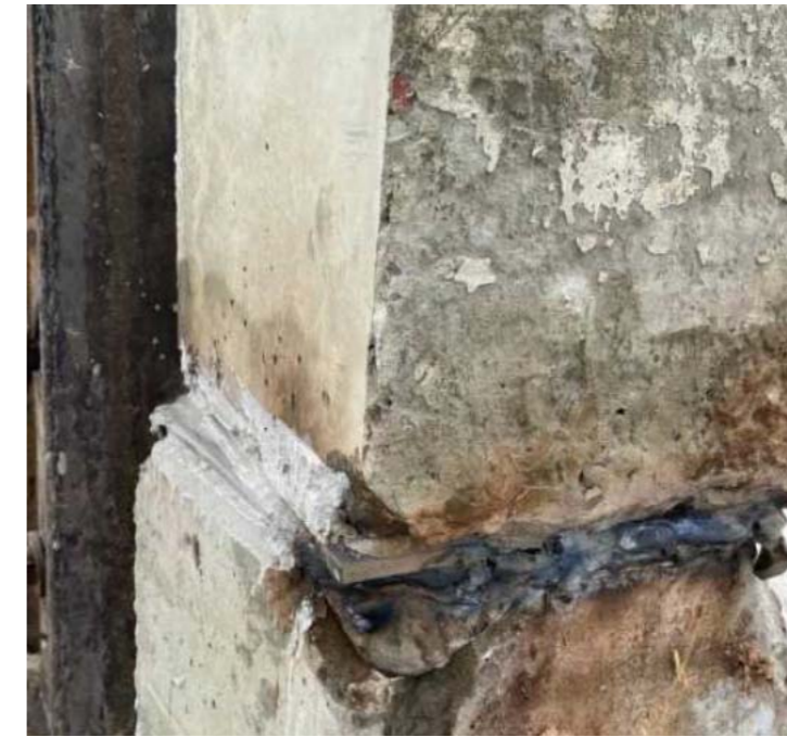
Рис. 1. Сварной стык железобетонной сваи
