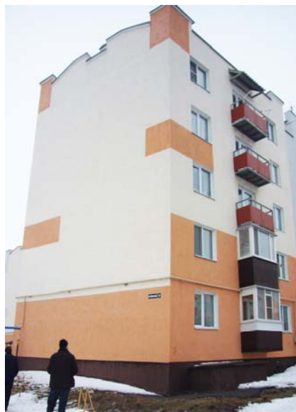
Рис. 1. Вид жилого дома №113 по ул. Новоселов
