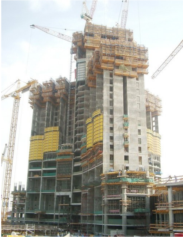
Abb. 3. Baustelle im Januar 2006
