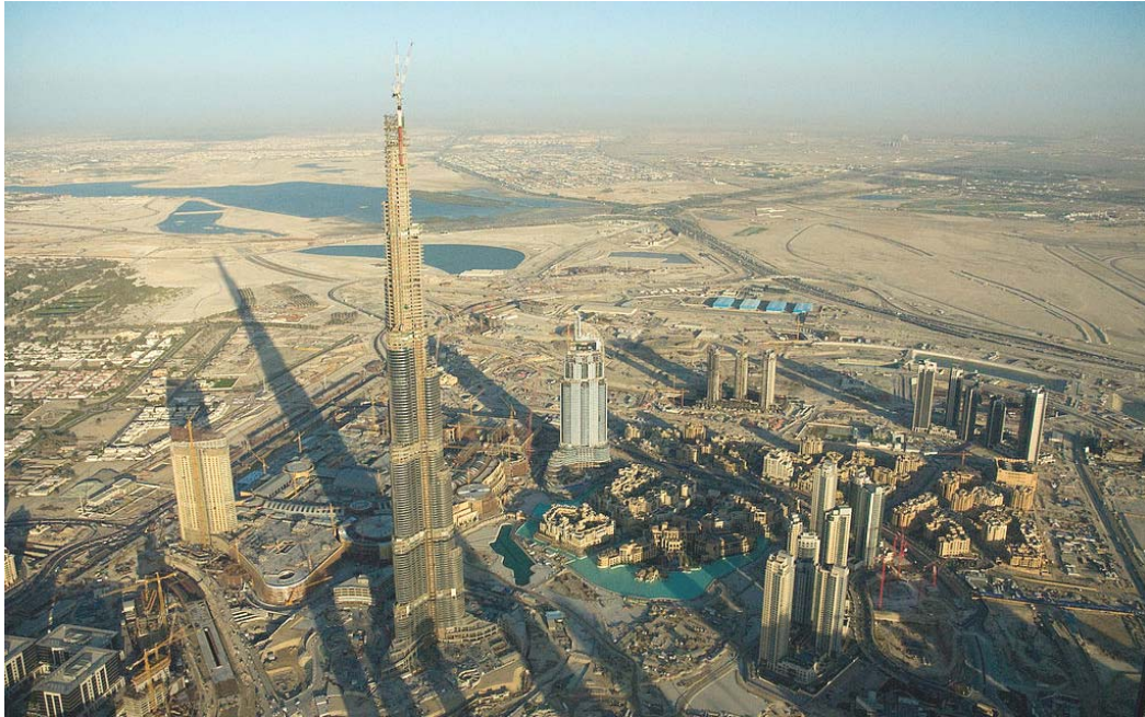
Abb. 2. Baustelle und Umland des Burj Khalifa am 11. März 2008
