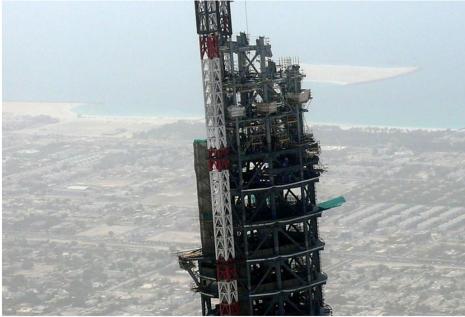
Abb. 7. Ansicht der Spitze der Baustelle (8. Mai 2008)
