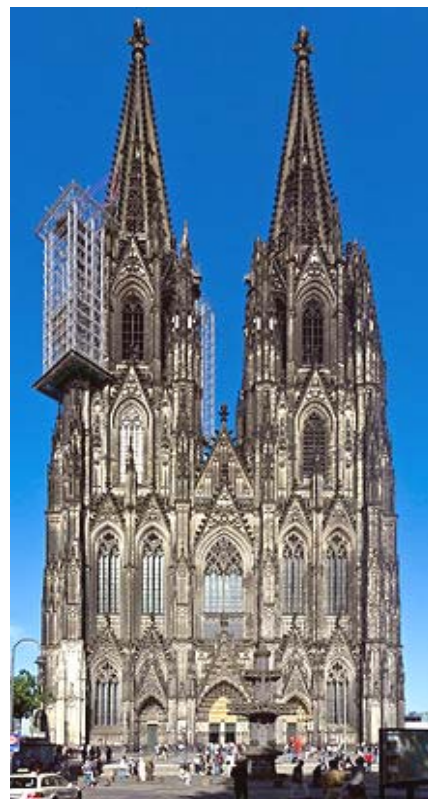
Abb. 5. Westfassade, 2013, Arbeitsgerüst mit Steinschlagschutz am Nordturm
