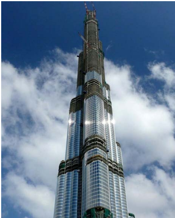
Abb. 5. Blick von unten auf die Baustelle am 25. Januar 2008
