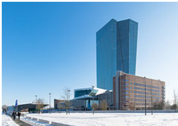
Neubau der Europäischen Zentralbank EZB-Hauptsitz mit Großmarkthalle, Hochhaus und Eingangsbauwerk
