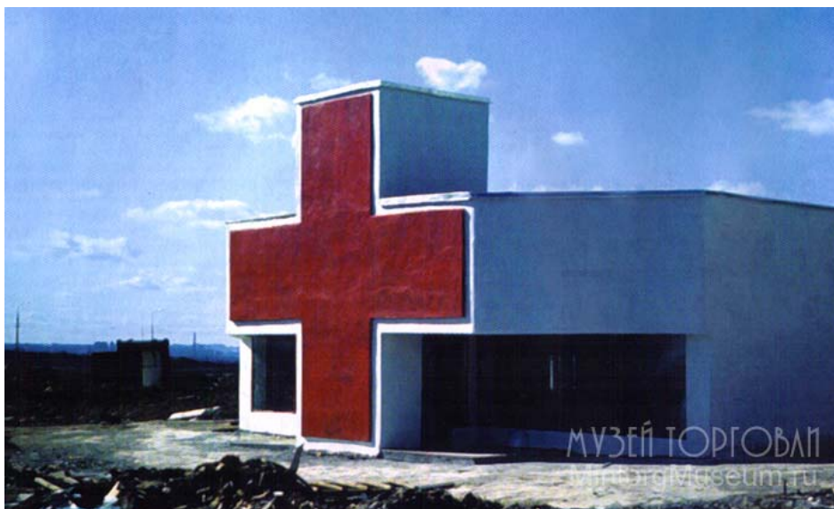
Рис. 115. Аптека в Москве. Один из образцов символизма в архитектуре. Арх. Е. Асс, А. Ларин
