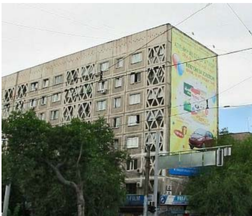
Рис. 99. Крупнопанельный экспериментальный 9-этажный жилой дом в Алма-Ате, 1970 г. Арх. В. Лейбо (Москва), инж. И. Еникеев (Алма-Ата)
