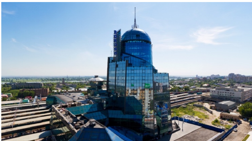
Рис. 170. Здание железнодорожного вокзала в Самаре. Арх. Юрий Храмов
