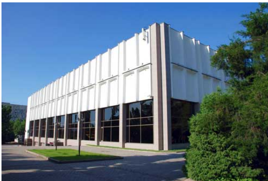
Рис. 94. Драматический театр в Алма-Ате, построенный по типовому проекту ЦНИИЭП зрелищных зданий, арх. Г Горлышков
