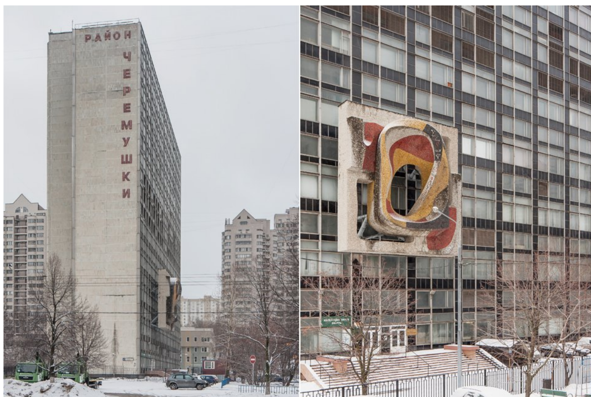
Рис. 103. Центральный Экономико-математический институт на Нахимовском проспекте. «Дом с ухом». 1967 год. Арх. Л. Павлов
