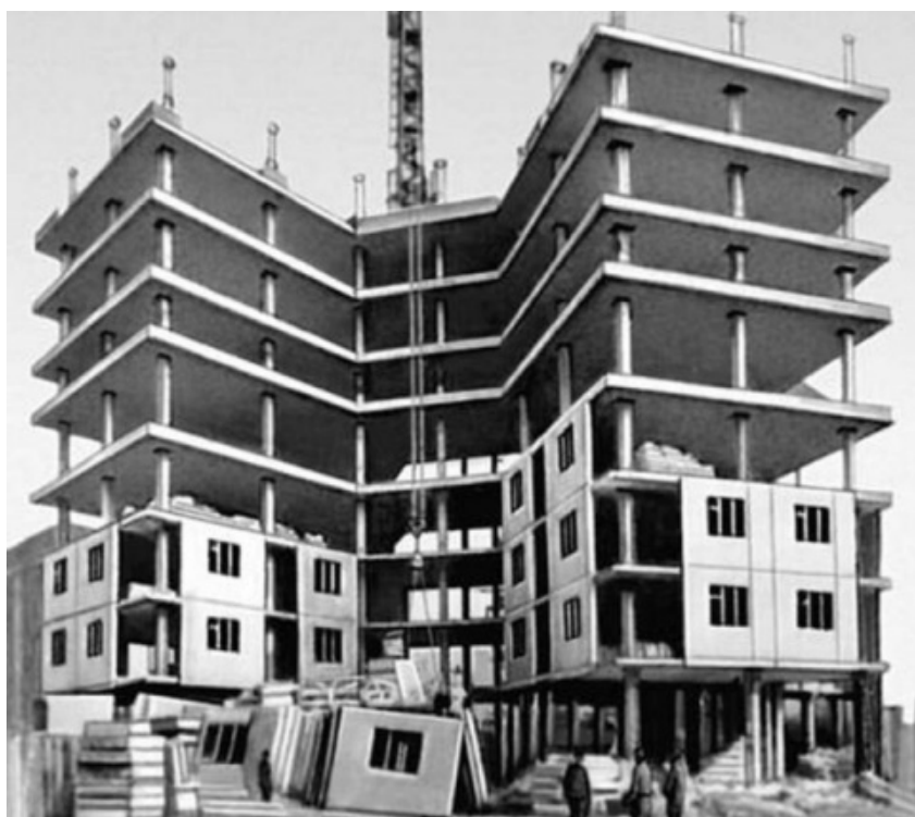
Рис. 100. Жилой 12-этажный экспериментальный жилой дом, возводимый методом подъема перекрытий
