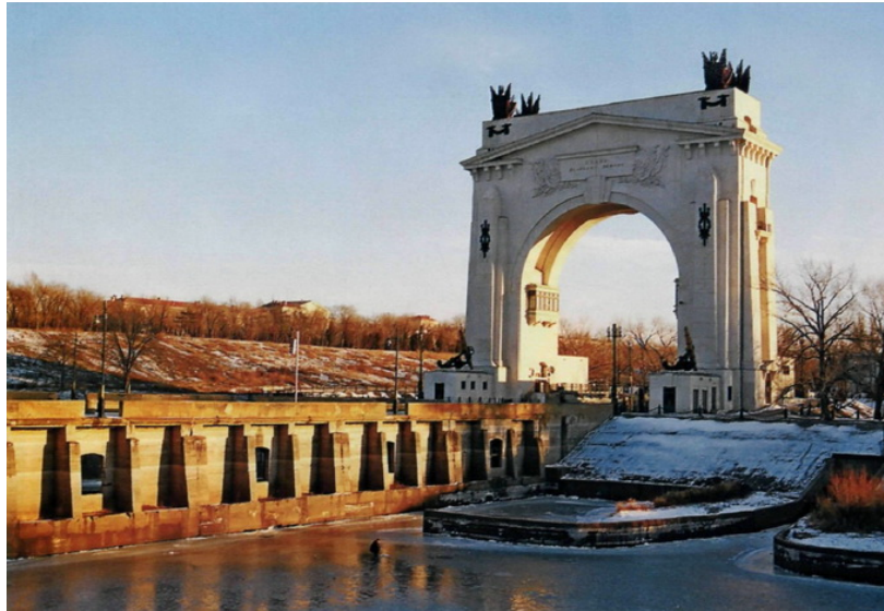
Рис. 81. Шлюз №1. Арх. Л. М. Поляков
