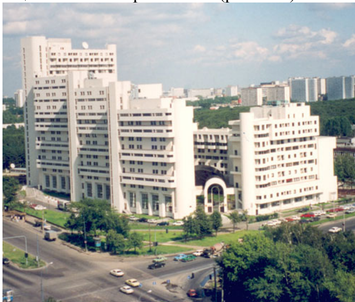
Рис. 147. Многофункциональный жилой комплекс «Парк-Плейс» в Москве на Ленинском проспекте. Авторский коллектив: Я. Белопольский, Л. Вавакин, Н. Лютомский
