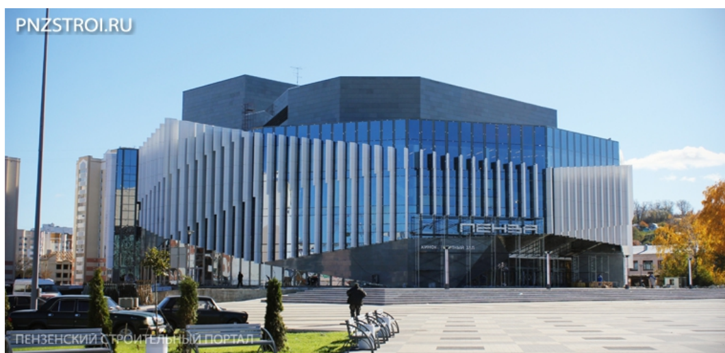
Рис. 181. Новое здание концертного зала на 1600 мест в стиле модерн. Автор Марат Каскеев
