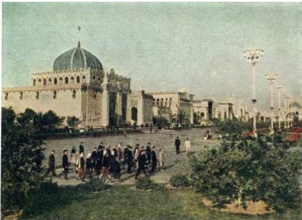
Рис. 73. Павильон Казахской ССР на ВСХВ. Здание венчает стеклянный купол в форме казахской юрты
