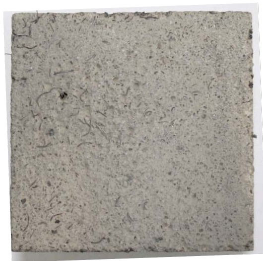
Рис. 4.15. Истираемая поверхность образца дисперсно-армированного мелкозернистого бетона
