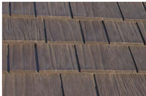
Рис. 5.1. Разработанные материалы на основе резиновой крошки: а, б – травмобезопасные покрытия; в, г – резиновая гибкая черепица
