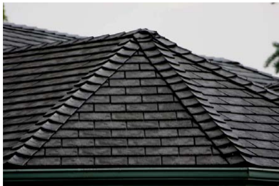
Рис. 5.1. Разработанные материалы на основе резиновой крошки: а, б – травмобезопасные покрытия; в, г – резиновая гибкая черепица
