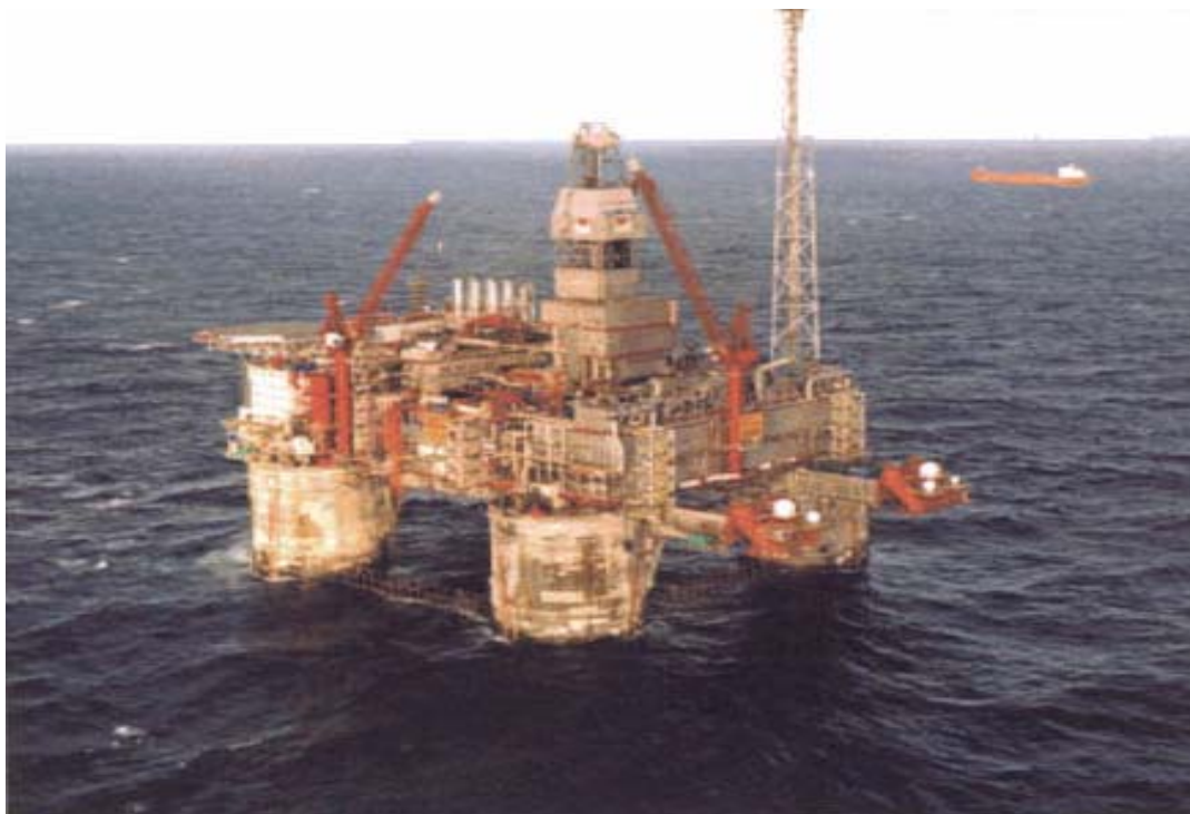
Рис. 1.2. Нефтяная платформа Heidrun Tension (Norway, 1995 г.). (Конструкция платформы из высокопрочного легкого бетона на заполнителях из вспученной глины (Liarog) при плотности \rho_0 = 1950 кг/м 3 и прочности на сжатие в возрасте 28-и суток R_{28} = 70 МПа)
