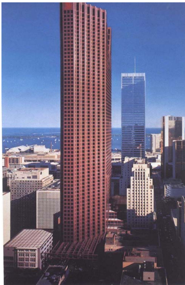
Рис. 1.5. Здание Scotia Plaza Tower (69 этажей, 276 м) в финансовом районе г. Торонто (Канада). Перекрытия высокой огнестойкости (класс К0 при \tau_{огн} = 2 час) выполнены из монолитного лёгкого бетона класса по прочности В20 – В30 марки по плотности D1800 – D1900 на основе пористого шлакового гравия (pelletized slag), 1990 г.
