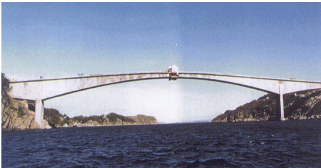
Рис. 1.3. Мост “Stolmen”, Норвегия, построен в 1998 г. ( L=94+301+72=467 м). (Конструкции главного пролета длиной 301 м выполнены из легкого бетона R_{28} = 70,4 МПа при \rho_0 = 1940 кг/м 3 на пористом заполнителе HF Леса 800 из вспученных глинистых сланцев)
