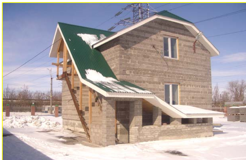
Рис. 1.6. Коттедж со стеновыми блоками и перемычками из беспесчаного поризованного керамзито-бетона марки D700 класса B2,5
