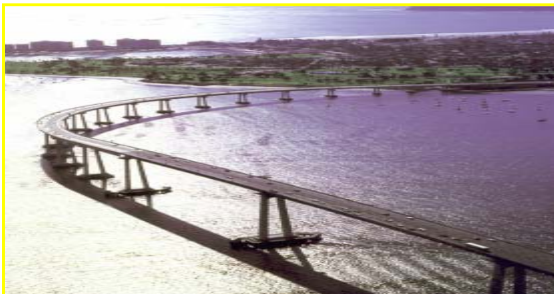
Рис. 1.4. Мост Coronado (California, USA, 1969 г.) из конструкционного легкого бетона прочностью R_{28} = 42 МПа при \rho_0 = 1840 кг/м 3 на заполнителе из вспученных глинистых сланцев
