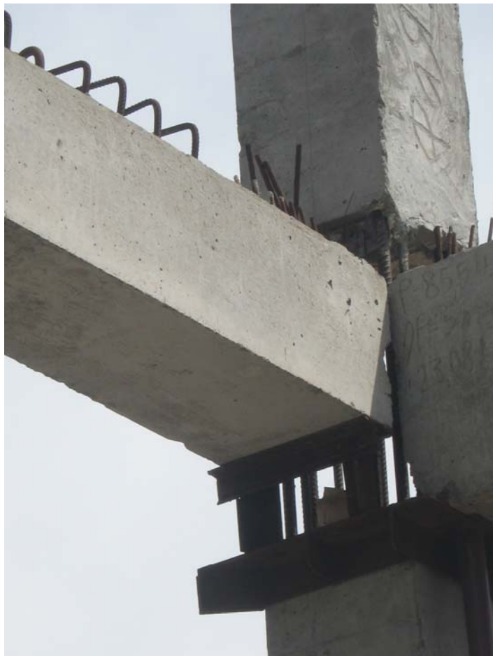
Рис. 2.12. Опорный узел продольного и поперечного ригелей
