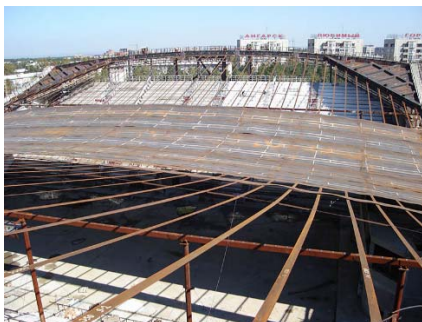
а) Ледовый дворец спорта «Ермак» в г. Ангарск в процессе строительства (раскладка полотнищ по временным элементам «постели»)
