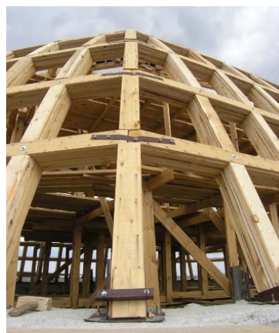
б) Законченный каркас ребристо-кольцевого купола
