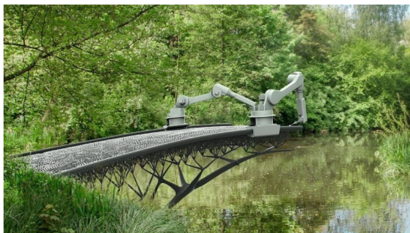
Рис. 8. Печать сварного моста над речкой (источник: http://www.dp.ru/a/2015/06/18/V_Gollandii_3D-printeri_p/gallery/24406/182257/ )
