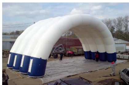
б) Воздуhonесомое сооружение (пневмомат), ООО ТЕНТ ПЛЮС
