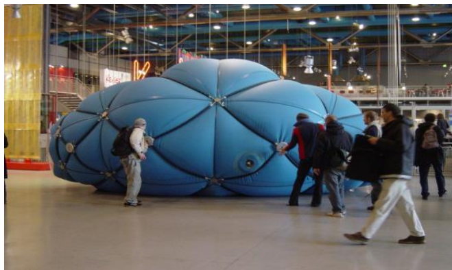
Модель программируемого павильона “NSA Muscle” из пневматической мембраны, обтянутой сеткой, 2003 г.
