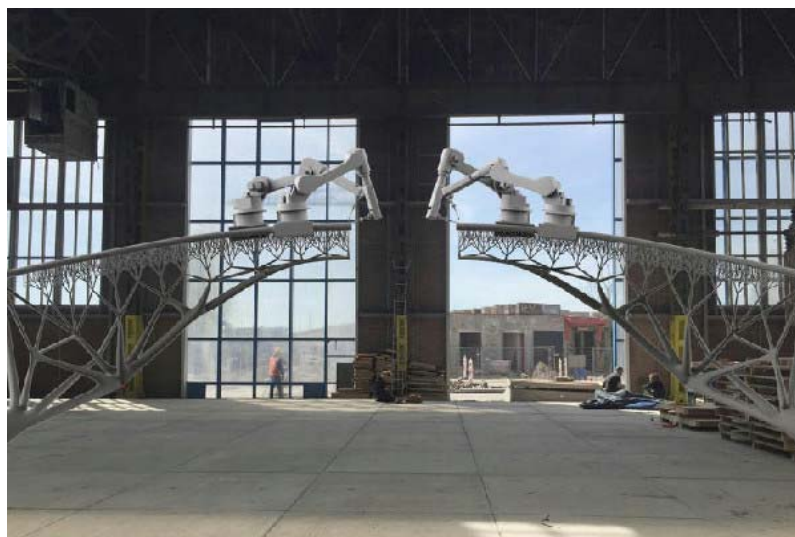
Рис. 7. Создание сварочной самоподдерживающей конструкции (источник: http://www.dp.ru/a/2015/06/18/V_Gollandii_3D-printeri_p/gallery/24406/182269/ )
