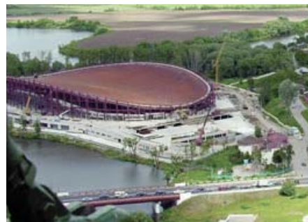
б) Крытый каток в г. Коломне в процессе строительства, введен в эксплуатацию в 2009 г., проектирование ЦНИИСК им. В.А. Кучеренко
