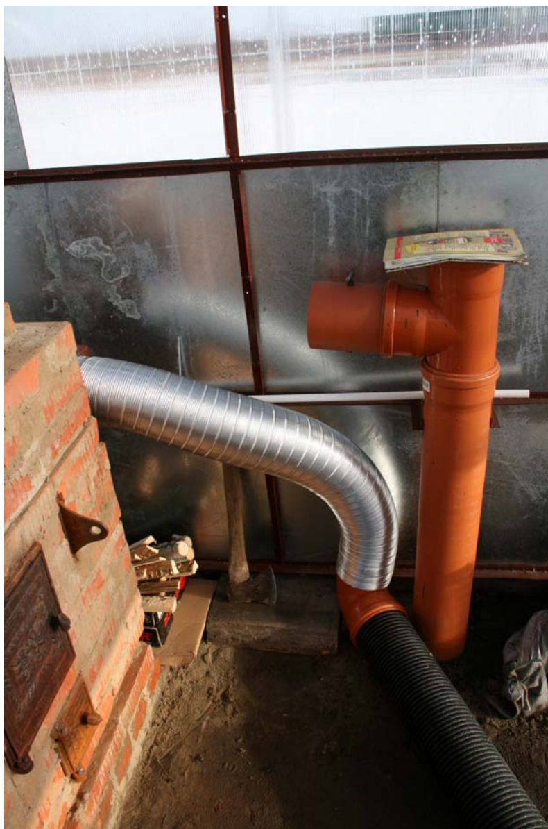
Рис. 4.20. Схема узла подачи воздуха в дополнительное укрытие
