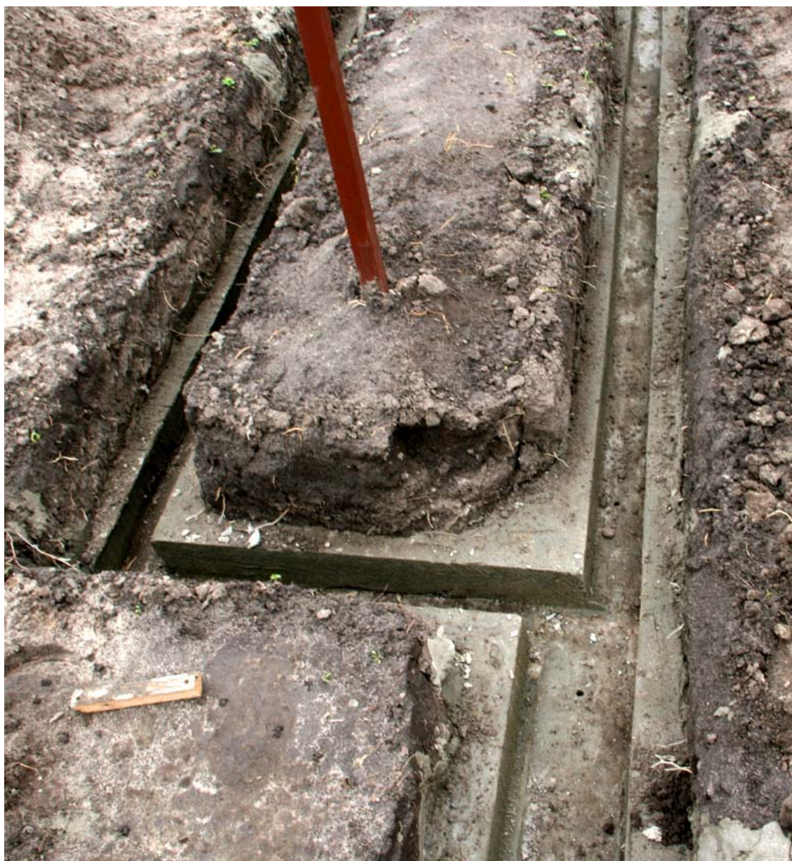
Рис. 3.5. Монтаж подпочвенных каналов из бетона
