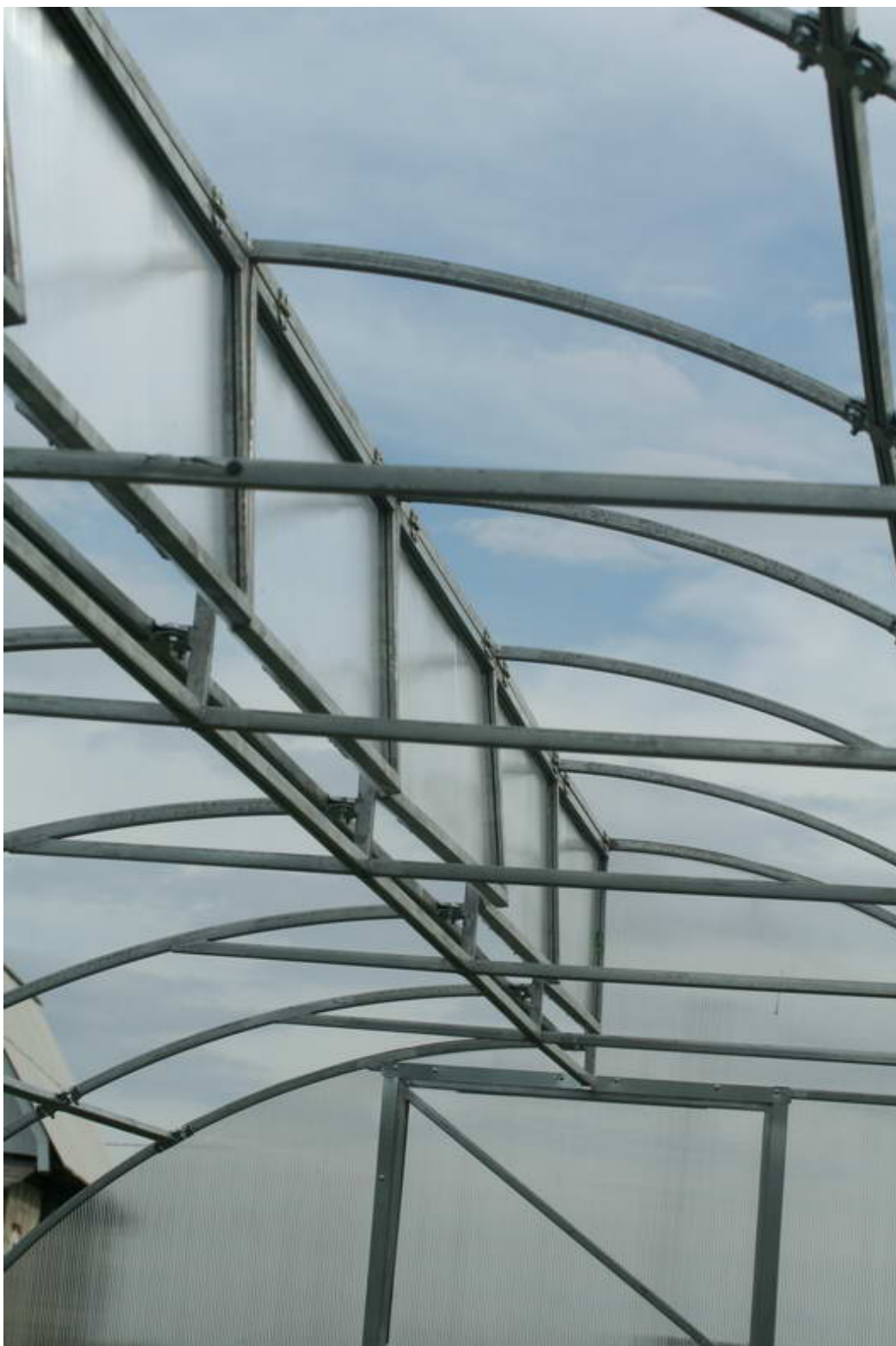
Рис. 6.4. Конструкции форточек теплицы «Митлайдер»
