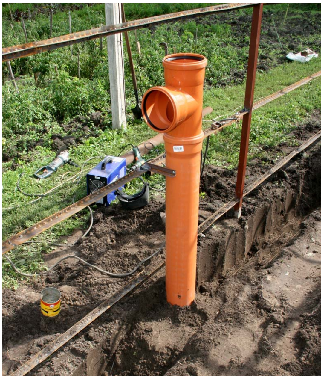
Рис. 3.6. Монтаж узла входа в почву и узла соединения теплообменника с системой теплоутилизации
