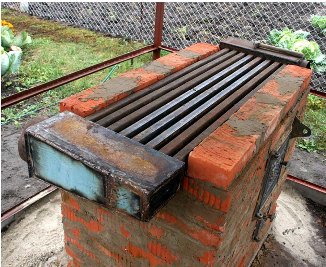
Рис. 3.8. Монтаж печи с газовоздушным теплообменником
