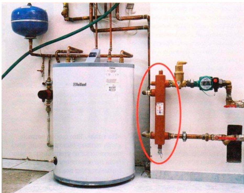
Рис.32. Термогидравлический распределитель
