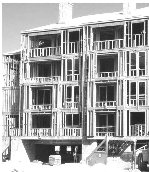
Рис. 76. Многоэтажный дом с деревянным каркасом
