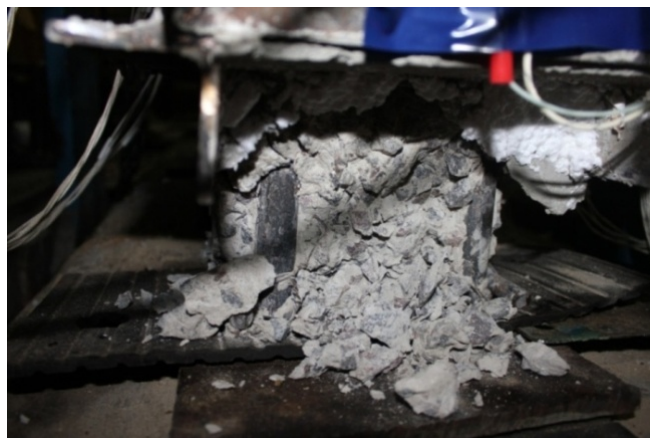
Рис. 3.39. Общий вид опорной части колонны при разрушении в зоне контакта её с силовым полом (вид снизу)
