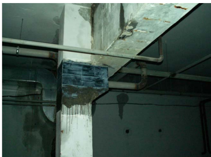
Рис.1.5. Усиление консолей с применением углепластика
