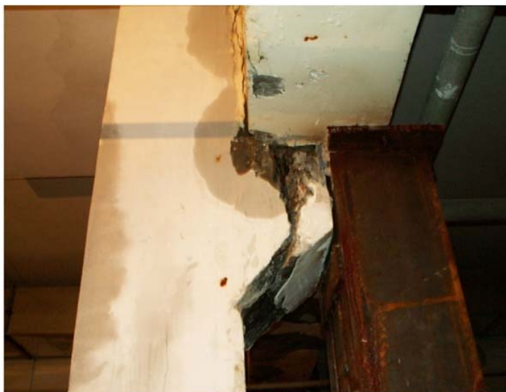
Рис. 1.4. Разгрузка аварийной консоли от воздействия балки
