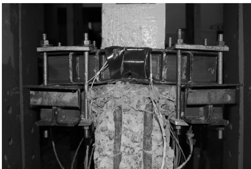
Рис. 3.23. Общий вид смятия бетона и полки центратора в зоне контакта
