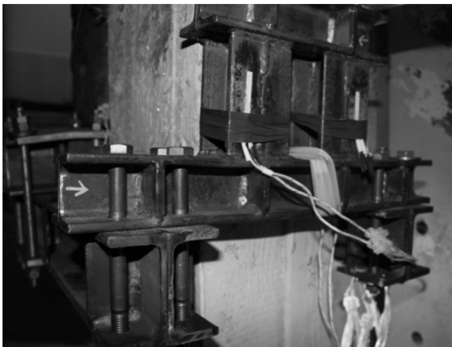
Рис. 3.28. Изгиб опорной балки
