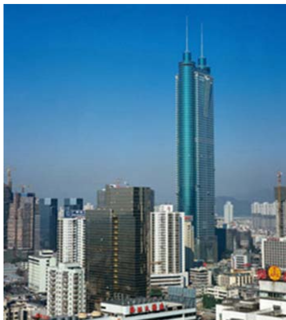
Рис. 6.8. Здание с каркасом из трубобетона на площади Сайгэ в Шэньчжэне, КНР (72 этажа)
