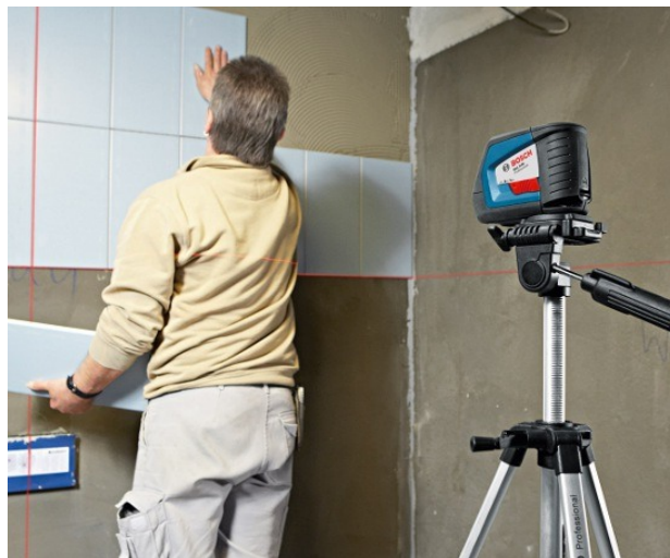
Рис.107. Нивелир «Bosch GLL 2-50 Professional», используемый в качестве ориентира для повышения точности ремонтных и строительных работ
