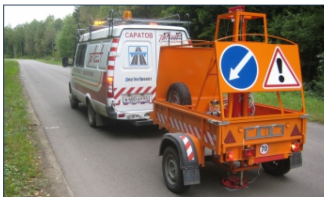
Рис. 4.13. Определение конструкции дорожной одежды при помощи бурильной установки СБ-ПМ «Колибри»
