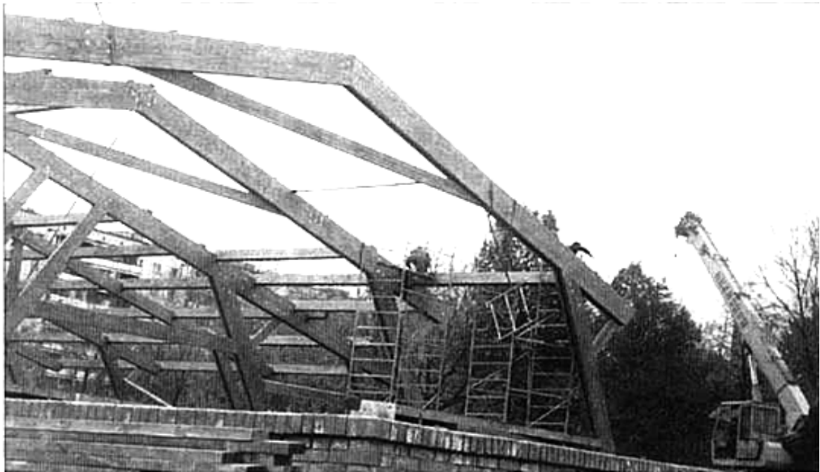
Рис.4. Рамные конструкции торгового дома Москва (ул. Сходненская)
