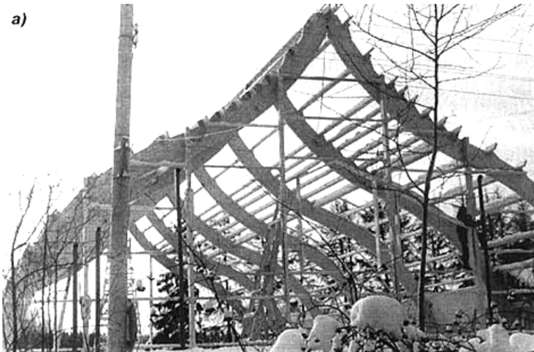
Рис. 5. Арочные конструкции теннисного корта в п.Снегири Московской области(пролет 18 м)
