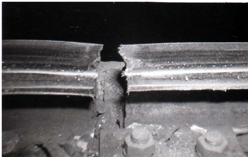
Рис. 1.7. Аварийный зазор в стыке рельсов
