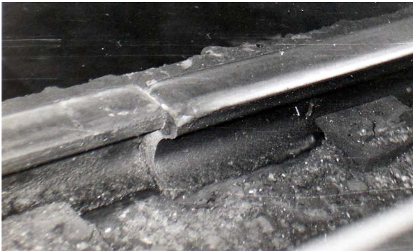
Рис. 1.8. Накладки отсутствуют. Опасное смещение рельса в стыке в поперечном направлении
