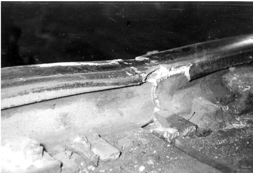
Рис. 1.11. Аварийное разрушение и выкрашивание сварного шва в стыке рельса над стыком смежных балок
